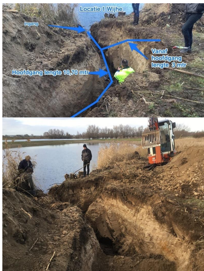
Figuur 2.5 Uitgegraven beverhol in de IJsseldijk (foto: WDOD).
