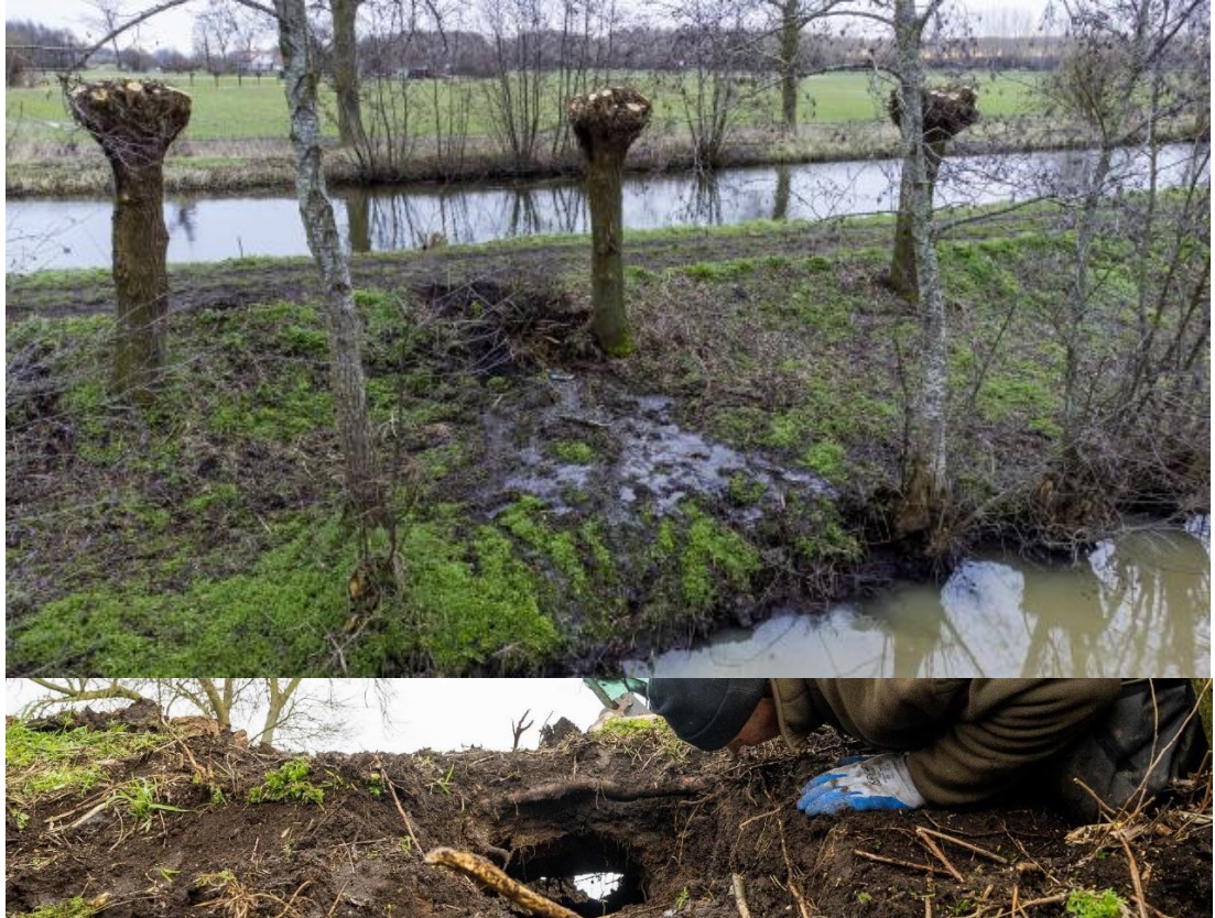
Figuur 2.6 Lekke Zijpkade bij Vianen door bevergraverij (foto's: WSRL).
