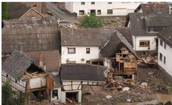
Figuur 2.8 Zwaar beschadigde huizen in district Ahrweiler langs de oevers van de Ahr. Boven: Verwoest huizenblok in Mayschoß; links: Grotendeels weggeslagen gevel in Schuld; rechts: Ondergraving van fundering in Altenahr.
