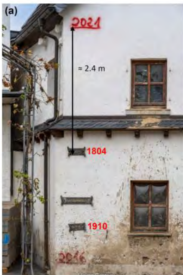
Figuur 2.9 Maximale waterstanden van historische hoogwaters en hoogwater 2021 op de gevel van huis in Dernau (regio Ahrweiler).
