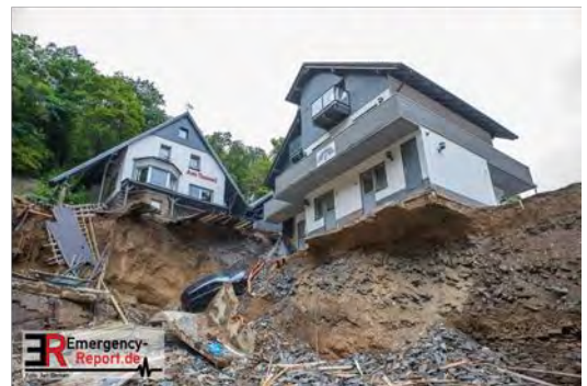
Figuur 2.8 Zwaar beschadigde huizen in district Ahrweiler langs de oevers van de Ahr. Boven: Verwoest huizenblok in Mayschoß; links: Grotendeels weggeslagen gevel in Schuld; rechts: Ondergraving van fundering in Altenahr.
