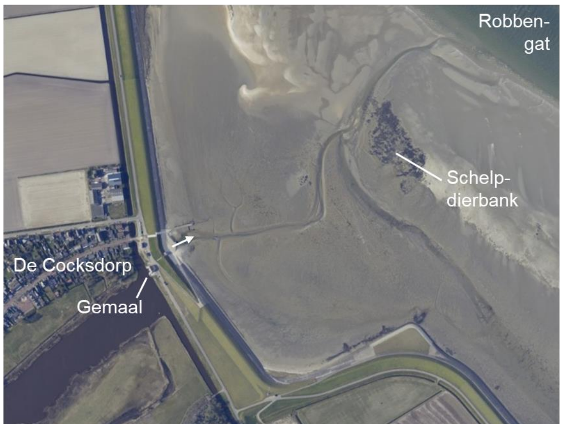
Figuur 2-9 Locatie van het gemaal bij De Cocksdorp (bron beeldmateriaal.nl).
