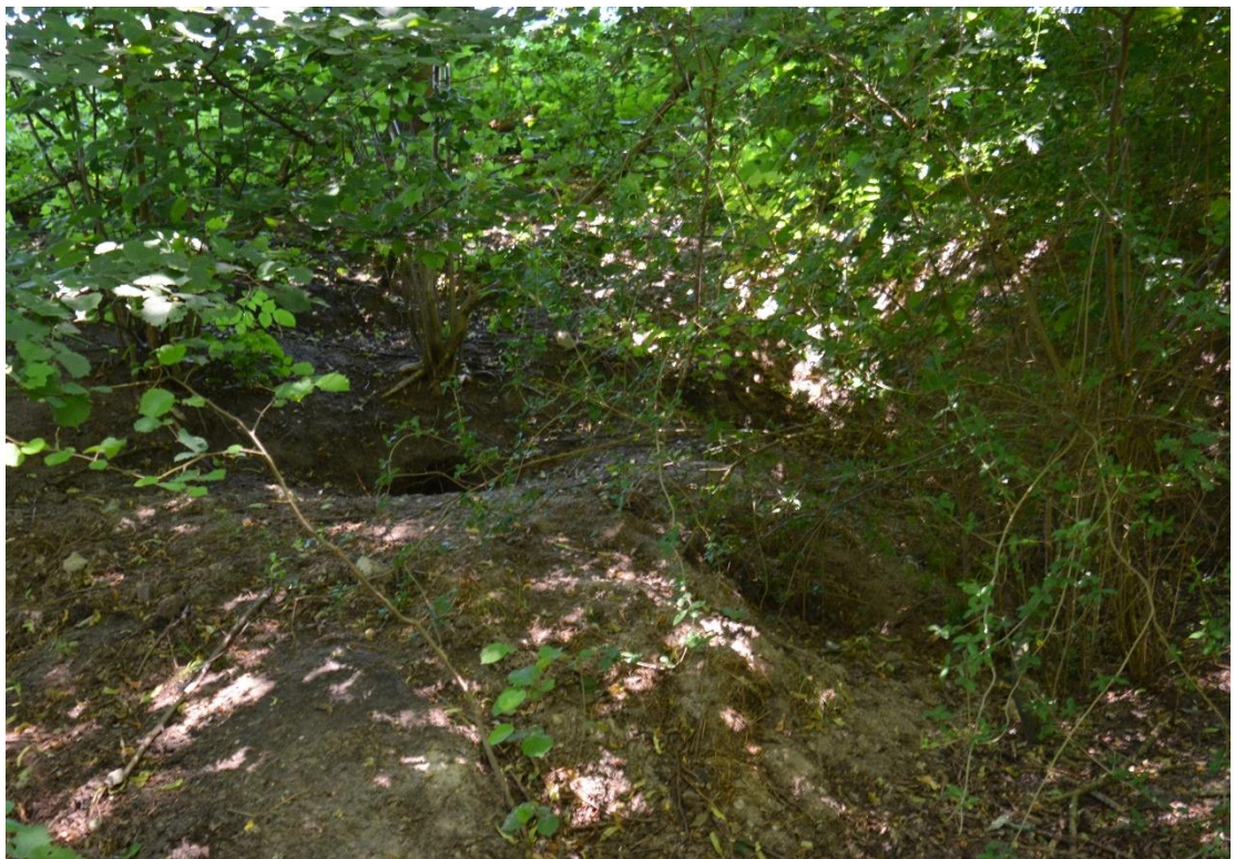
Figuur 2.20 Gedeelte van een dassenburcht in een regionale kering nabij Beilen. Meerdere graafpijpen zijn zichtbaar, maar lang niet alle graafpijpen van deze burcht staan afgebeeld. (eigen foto)
