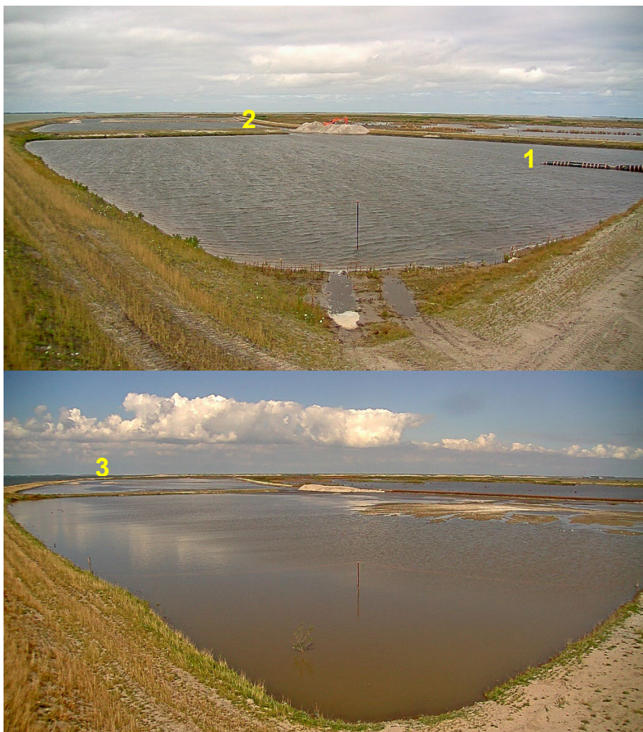
Figuur 4-1 Foto's van de dunslibcompartimenten vlak voor (boven) en vlak na (onder) de eerste vulslag (resp. 15 juli en 29 augustus 2019). Vulpunten aangeduid met cijfers 1, 2 en 3.
