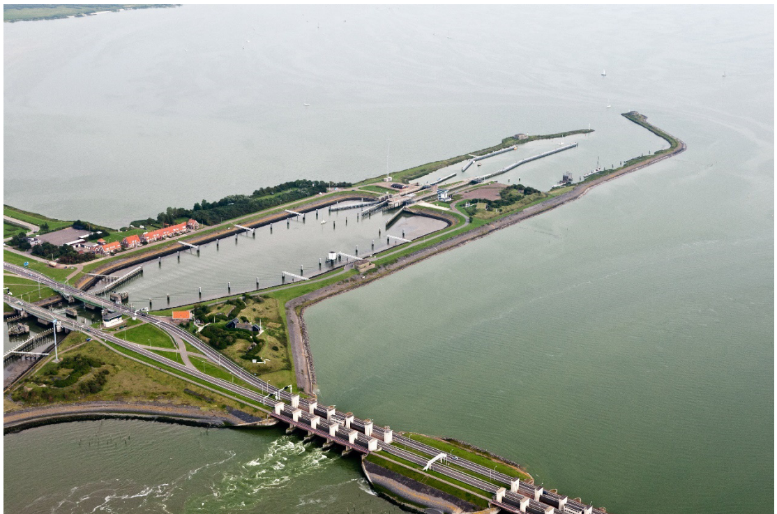
Figuur 1-1 Lorentzsluizen in de Afsluitdijk bij Kornwerderzand. Op de voorgrond de spuisluizen, in het midden de grote en kleine scheepvaartsluis met rechts daarvan de Binnenhaven en het IJsselmeer (bron: https://beeldbank.rws.nl , Rijkswaterstaat / Joop van Houdt).
