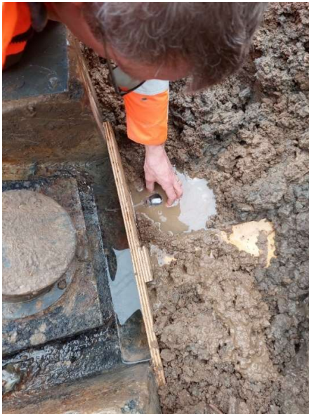
Figuur 5: Debietmeting en nemen watermonsters anker 08.
