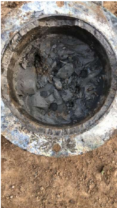
Figuur 6: Gedemonteerde ankermuts van anker A8.
