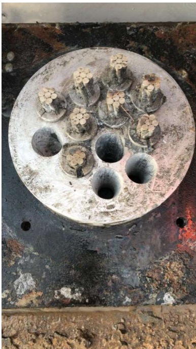
Figuur 7: Schoongemaakte ankerkop van anker A8.
