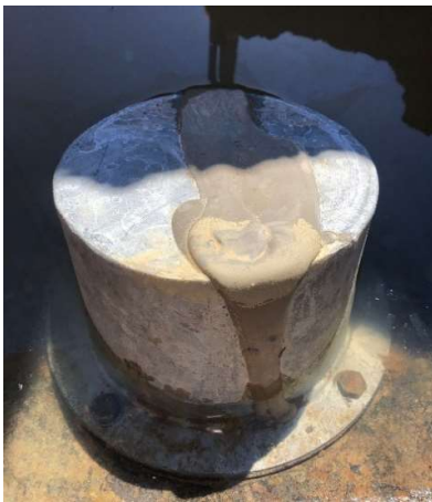
Figuur 9: Nieuwe ankermuts aangebracht en volgegrouet.
