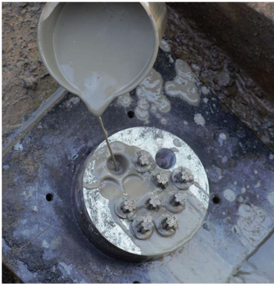
Figuur 8 Volgrouten van de ankerkop.
