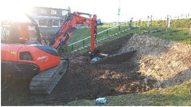
Figuur 102: Ontgravingswerkzaamheden bij raai 1.
