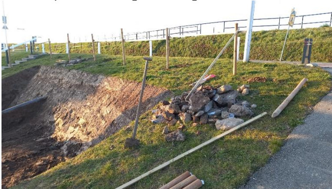
Figuur 103: Aangetroffen puin in ondergrond bij raai 1.
