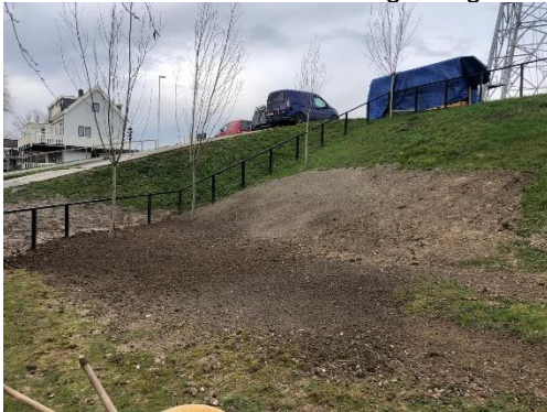
Figuur 105: Raai 4 afgewerkt na uitvoering installatie monitoring.
