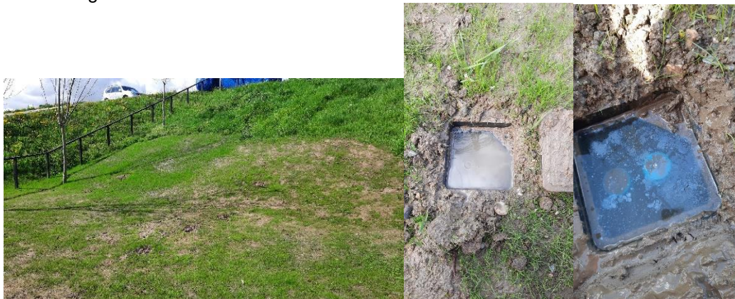
Figuur 106: Raai 4 afgewerkt na uitvoering installatie monitoring, maar natte plekken op talud (links); 2 foto's rechts wat in peilbuisputjes.
