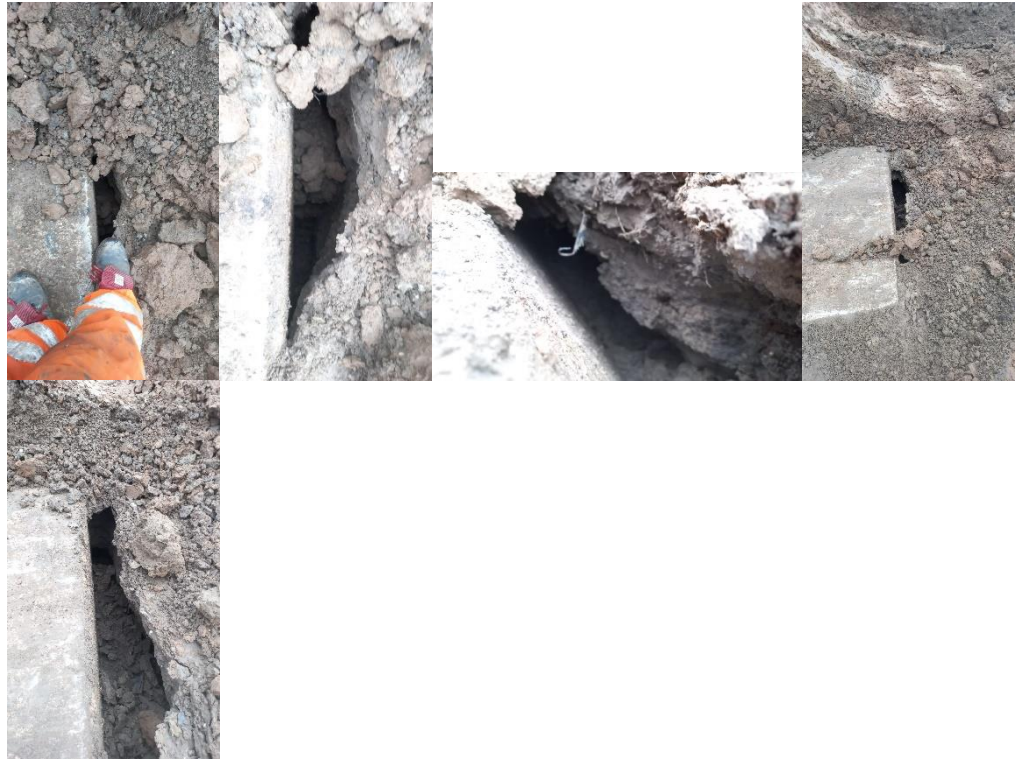
Figuur 110: Spleten langs de deksloof (aan polderzijde 15 cm breed en 60 cm diep (raai 6). Geen uittredend water waargenomen).
