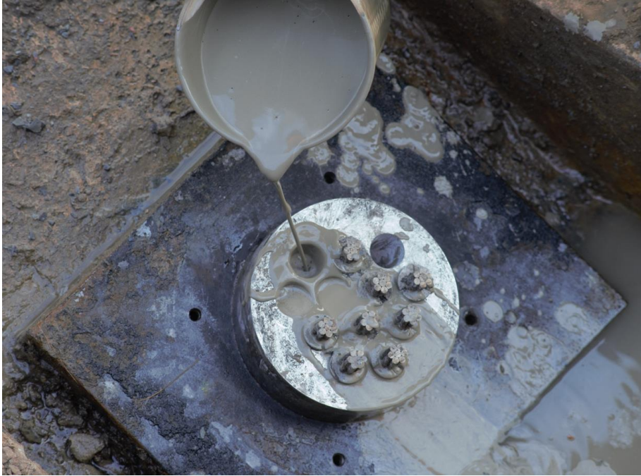
Figuur H.5 Grouten van de ankerstoel.
