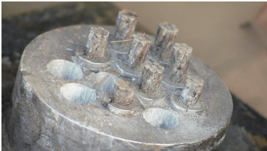
Figuur H.4 Close-up van de ankerstoel.
