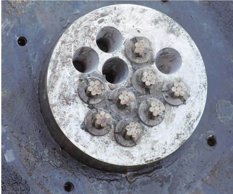
Figuur H.3 Schoongemaakte ankerstoel met wiggen.
