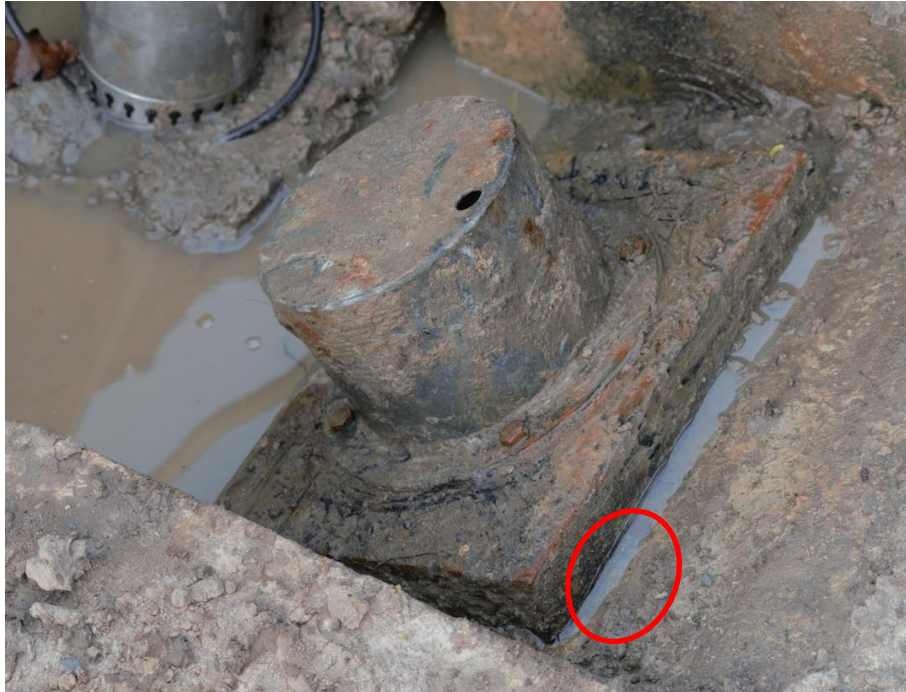
Figuur H.1 Ankerkop zoals aangetroffen met rode markering waar het lek langs het anker zit.
