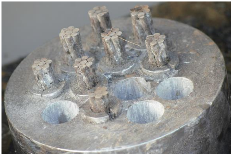
Figuur 4.3 Wiggenblok Anker A8 sectie F2.
