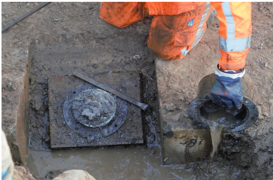
Figuur H.2 Ankerstoel met wiggen en strengen na verwijderen ankerkop.
