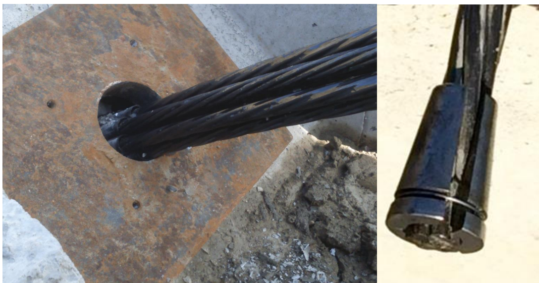
Figuur 3.5 Detailfoto van de ankerstrengen door de ankerplaat en rechts de wig over de streng.
