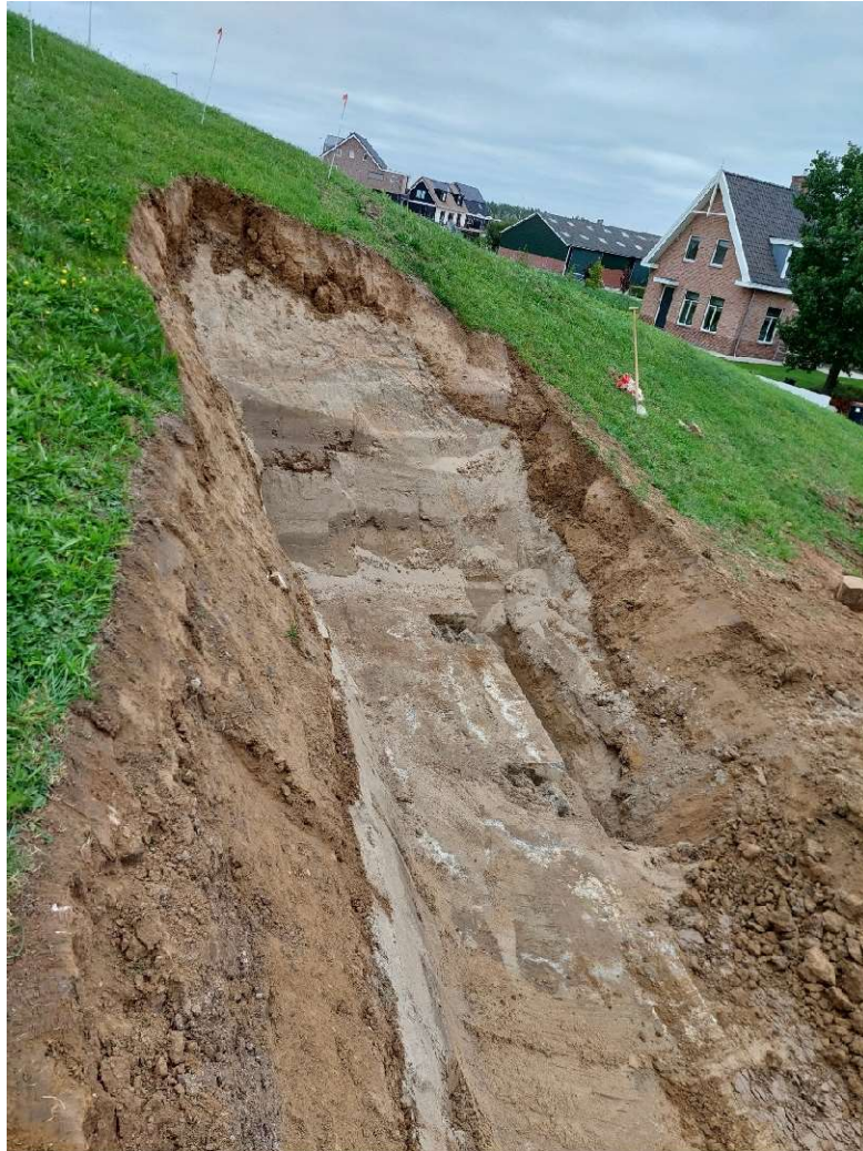
Figuur 1-23 Zand in opbouw bij locatie L2.
