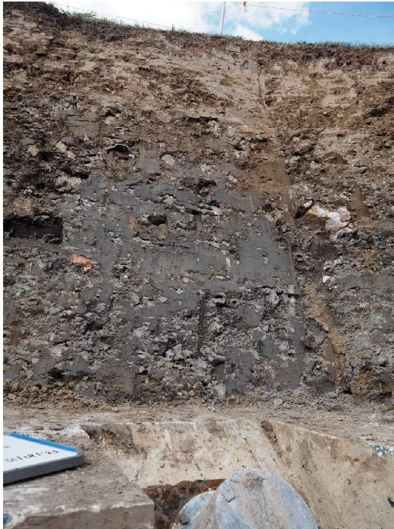
Figuur 1-17 Puin in wand van talud zichtbaar locatie XY.
