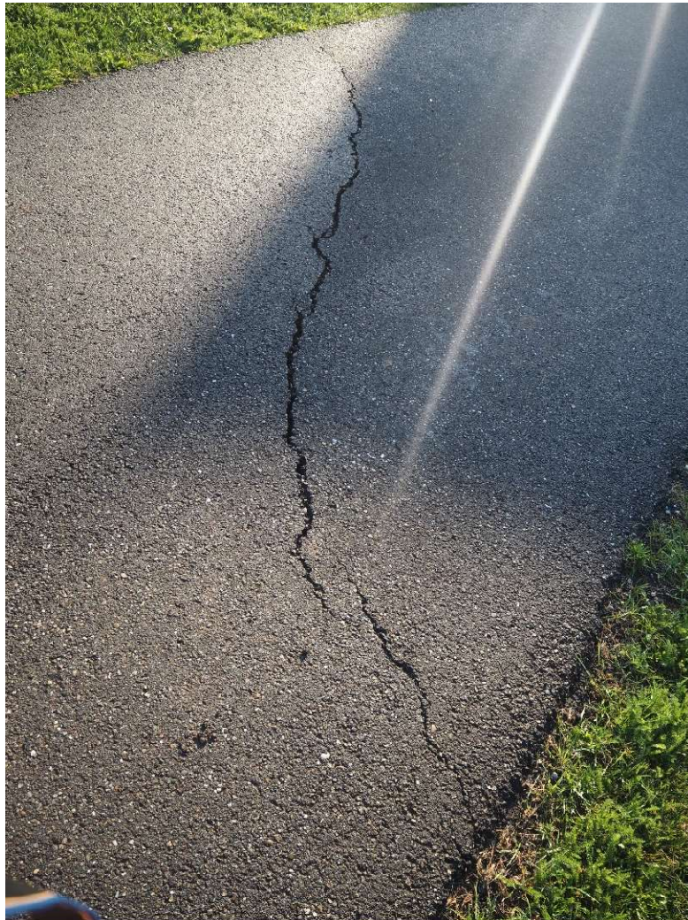
Figuur 1-14 Scheuren asfalt locatie XY.
