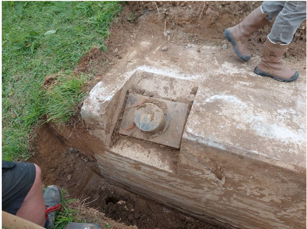
Figuur 1-22 Slijtage rand deksloof bij anker 34 op locatie L2.
