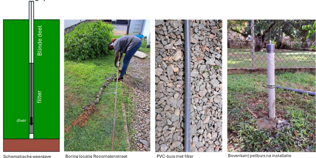
Figuur 3.3: Stappen voor plaatsen ondiepe freatische grondwater peilbuis.
