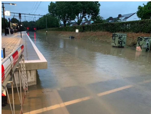
Figuur 1.3 Ondergelopen spoorwegovergang bij Bunde, tijdens de wateroverlast van 29 juni 2021. Bron: https://nos.nl/artikel/2387253-straten-en-spoor-in-zuid-limburg-blank-door-zware-regenval .
