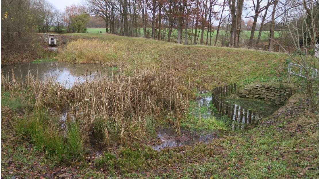
Figuur 3.5 Regenwaterbuffer Groenstergracht, nabij Eygelshoven (Foto N. Asselman)
