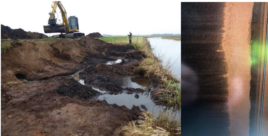
Figuur C.6 Ontgraven beverhol langs de Hunze - rechts beelden van de sonar over de kade langs de Hunze waarvan de dikkere streepjes horizontaal de bevergangen zijn (bron: M. Rothengatter, 2023).
