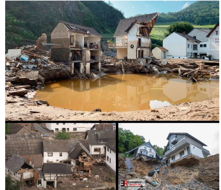
Zomer-hoogwater 2021: Zwaar beschadigde huizen in district Ahrweiler langs de oevers van de Ahr. Boven: Verwoest huizenblok in Mayschoß; links: Grotendeels weggeslagen gevel in Schuld; rechts: Ondergraving van fundering in Altenahr.
