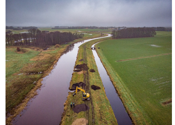
Ontgraven en herstellen van beverholen langs de Hunze over een lengte van 550 m (bron: Waterschap Hunze en Aa's)
