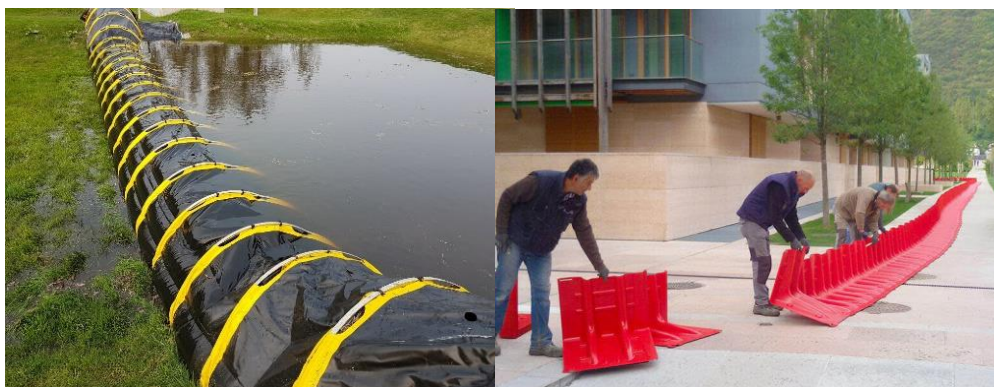
Figuur 40: Grootschalig flexibele waterkering. Links: Tubebarrier. Rechts: Waterschot mobiele waterkeringen
