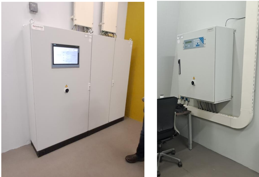
Figuur 24: Besturingskasten, van de kleppen (afbeelding links) en van de afsluiter vispassage (rechts)
