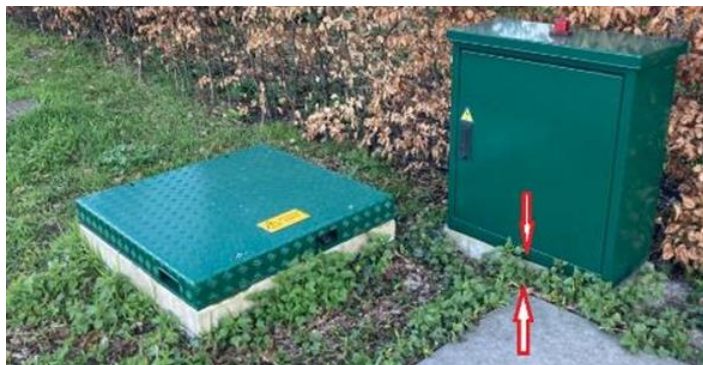
Figuur 36: Voorbeeld drukrioolgemaal (ook weer 10cm hoge sokkel), kwetsbare elektra in kast begint ook weer 10 a 20 cm hoger dan onderkant kast
