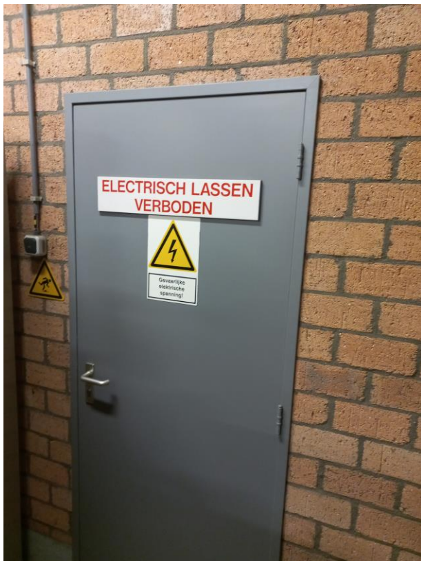
Figuur 22: Elektrische ruimte niet toegankelijk
