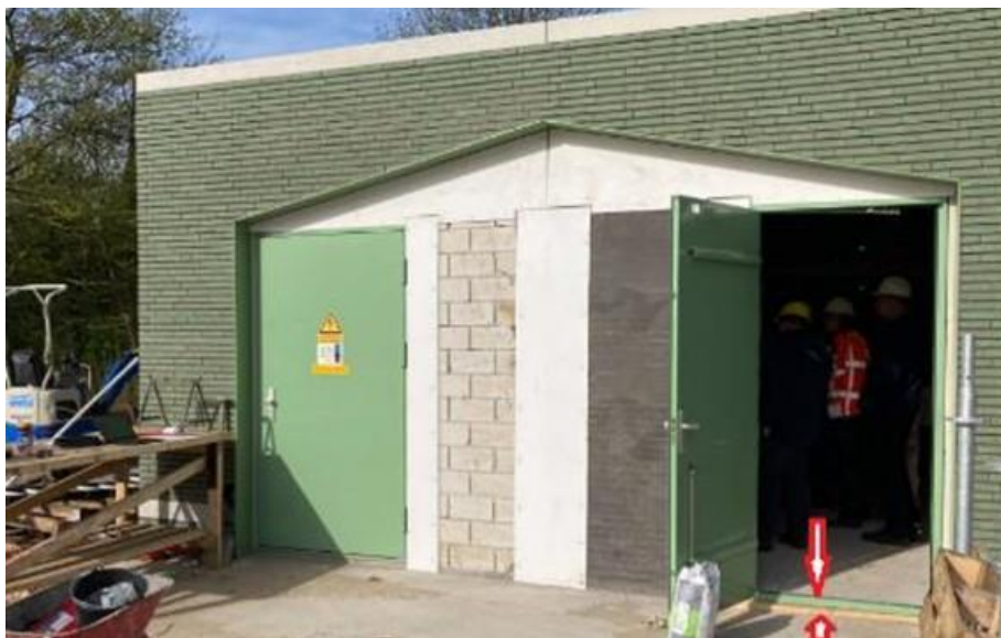
Figuur 30: Drempel en deuren van bovengrondse ruimtes sowieso (al jaren) 5 a 10 cm boven maaiveldniveau
