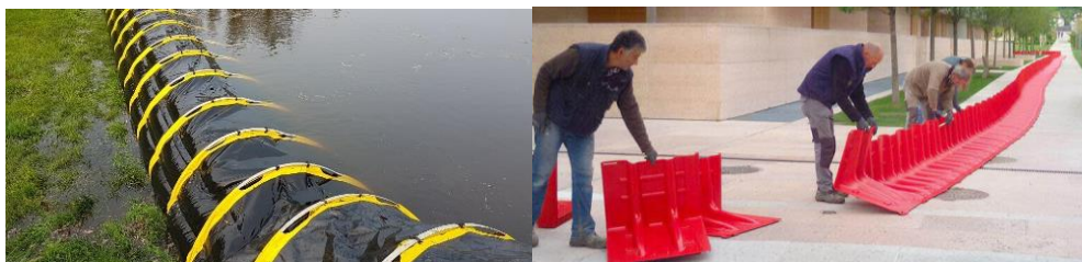
Figuur 9: Grootschalig flexibele waterkering. Links: TubebARRIER. Rechts: Waterschot mobiele waterkeringen
