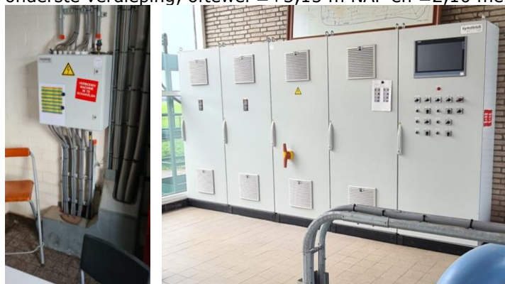
Figuur 26: verdeelkast (afbeelding links) en besturingskasten (rechts)
