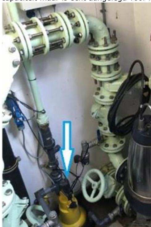
Figuur 32: Voorbeeld van een lenspomp (hier in droge ruimte twee-pomps-droog gemaakt, zilver object een normale rioolpomp)
