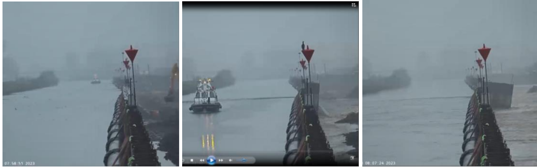
Figuur 2.5 Screenshots uit bewakingscamera a) 7.58 welvorming b) 8.02 translatie damwand c) 8.07 openklappen wand.
