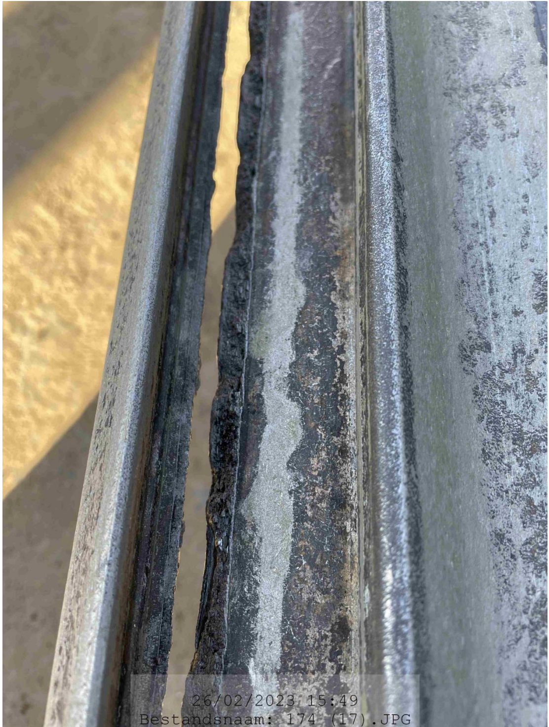
Figuur 3.3 Slot plank 174A losgescheurd.
