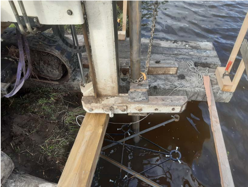
F003; installeren waterspanningsmeters
