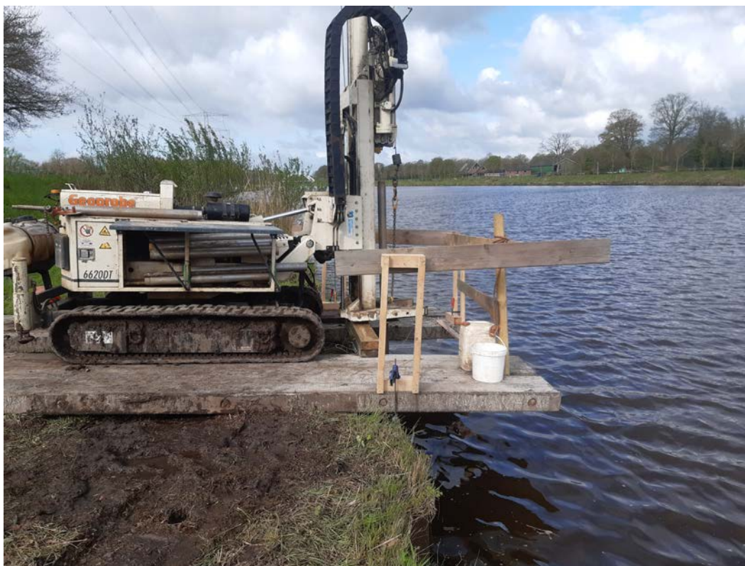
F002; installeren waterspanningsmeters
