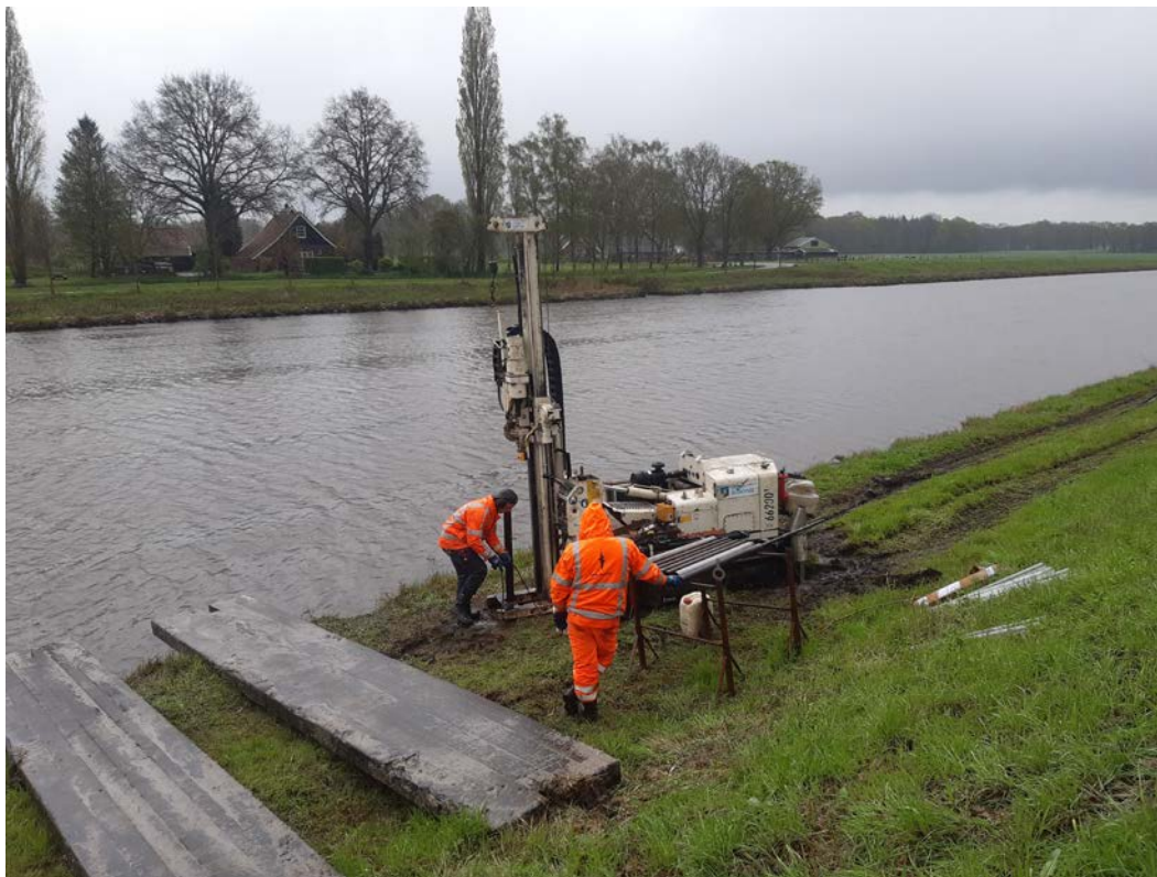
F001; uitvoeren machinale boring
