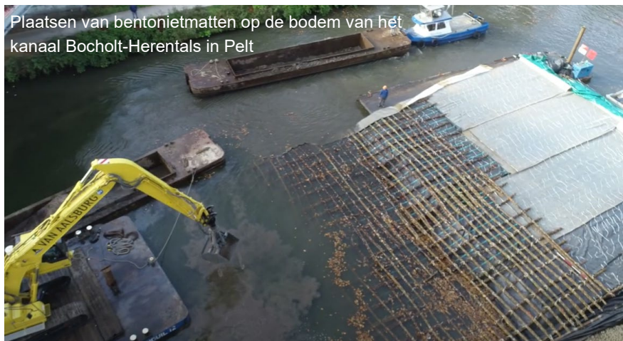
Figuur 2.2 Plaatsen van bentonietmatten bij Pelt in België (bron: Van Aalsburg).
