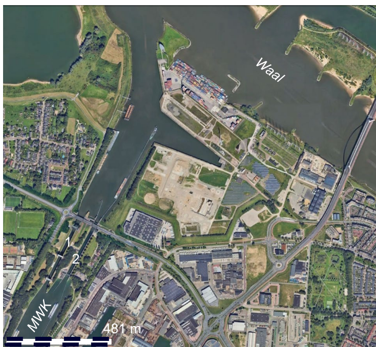
Figuur 3.1: Bovenaanzicht Sluis Weurt (bron: Google Earth). 1=Westsluis; 2=Oostsluis; MWK=Maas-Waalkanaal
