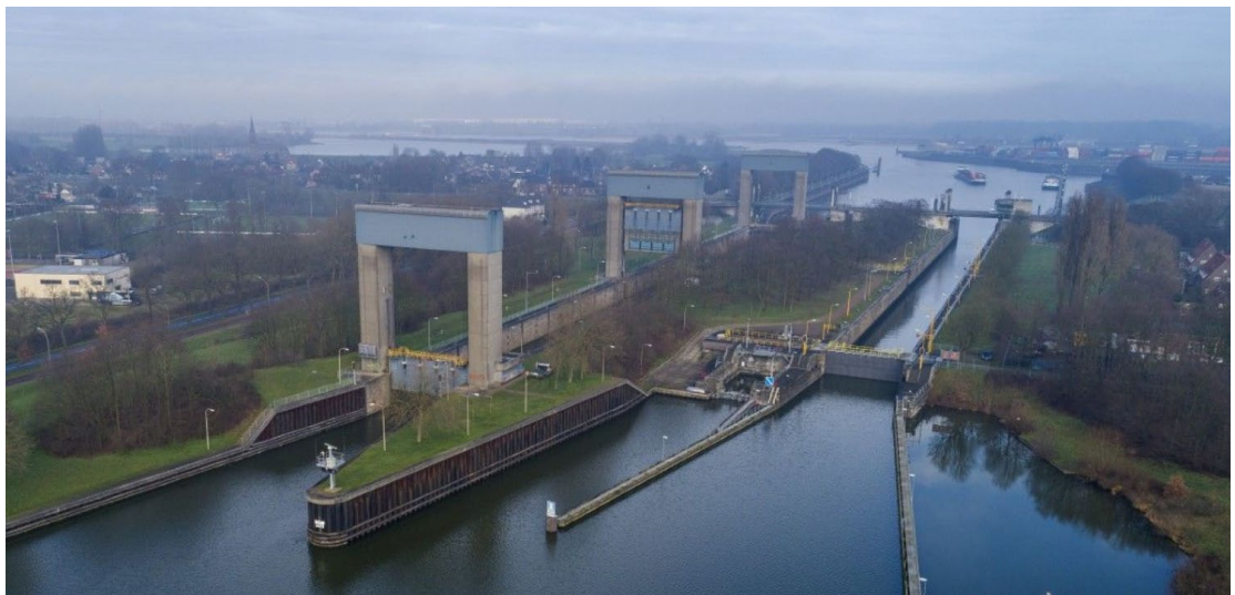
Figuur 1.1: Sluis Weurt met links de Westsluis en rechts de Oostsluis en op de achtergrond de Waal (© Rijkswaterstaat; via website omroep Gelderland)
