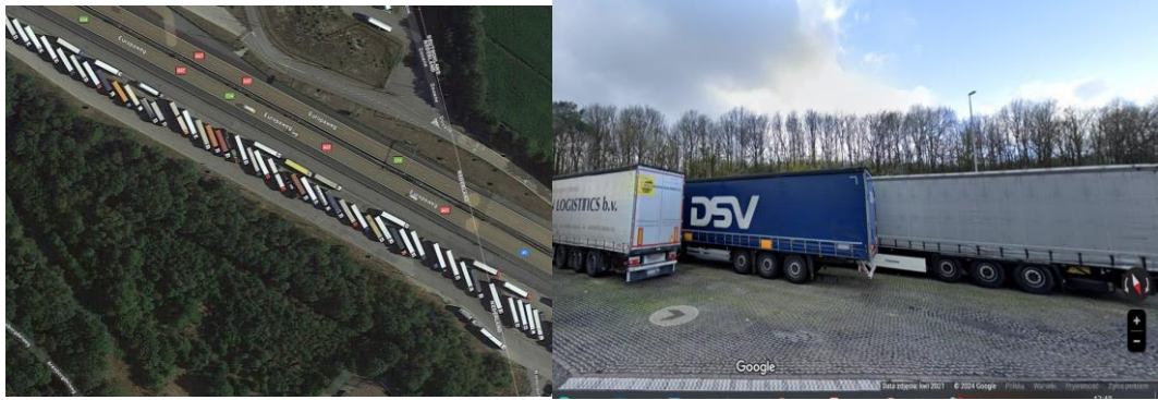
Figuur 2-5: Doorgroeibare verharding op verzorgingsplaats langs de A67 nabij Venlo (Bron: maps.google.com voor meer foto's en locatie: https://climatescan.org/projects/16723/detail ).
