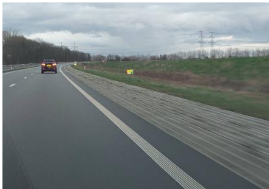
Figuur 2-6: Doorgroeibare verharding als vluchtzone/berm langs de N280 ( https://www.climatescan.nl/projects/13097/detail ).
