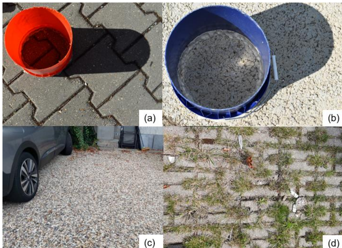
Figuur 1-1: a) Waterpasserende stenen hierbij zakt het water weg tussen de stenen. b) Waterdoorlatende verharding: hierbij zakt regenwater weg door de verharding zelf. c) Halfverharding: dit bestaat uit onsamenhangend materiaal dat is verdicht, zoals grind- of schelpenpaden. d) is doorgroeibare verharding
