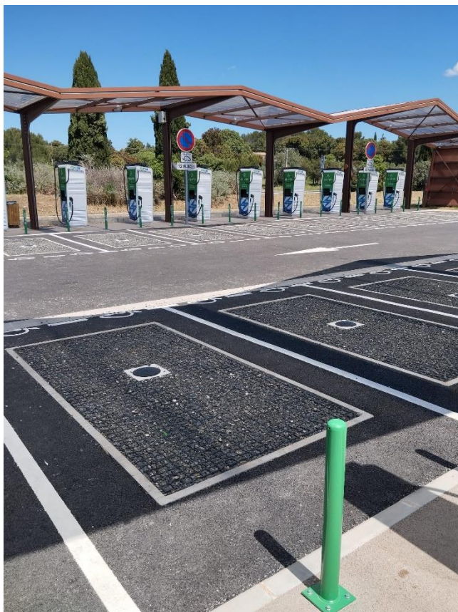
Figuur 3-1: Doorlatende verharding op een verzorgingsplaats in Frankrijk (foto via Anne Rhebergen, RWS).
