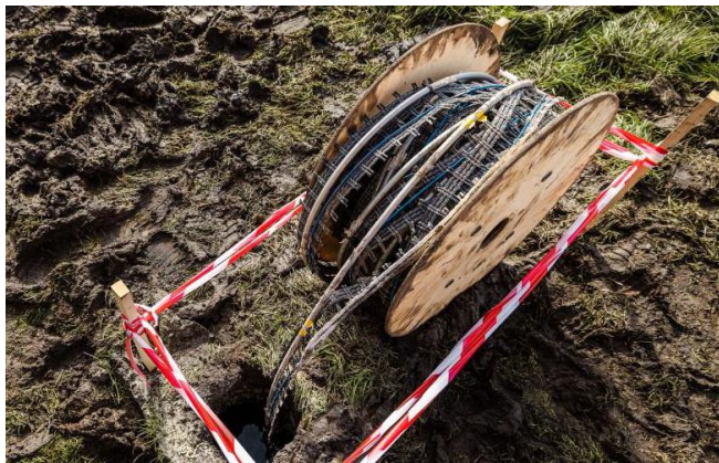
Figuur 4.2 Glasvezel verbonden met geogrid (bron: Waterschap Hollandse Delta).
