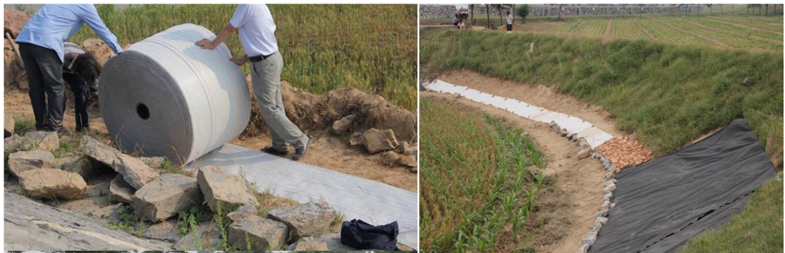
Figuur 4.5 Uitrollen van de textielrol waarin de glasvezels zijn aangebracht. (Bron: Deltares).
