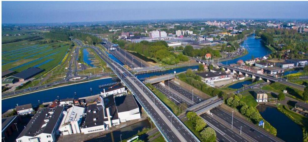
Figuur 1: Het Gouwe aquaduct © Rijkswaterstaat
