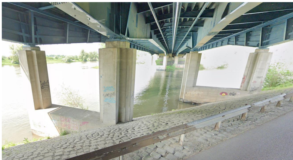
Figuur 19 Brugpijlers in de haven bij De Steeg (bron: Google Street View).
