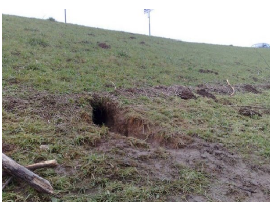
Figuur bijlage A.10 Graverijen in waterzijdig talud (links: Van Dam, 2024:12, rechts: Evers & Cornelisse, 2021:21)
