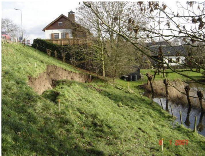
Figuur bijlage A.12 Afschuiving halverwege talud met steile klif in de Zuiderlingedijk, Spijk (Van Hoven, 2014).
