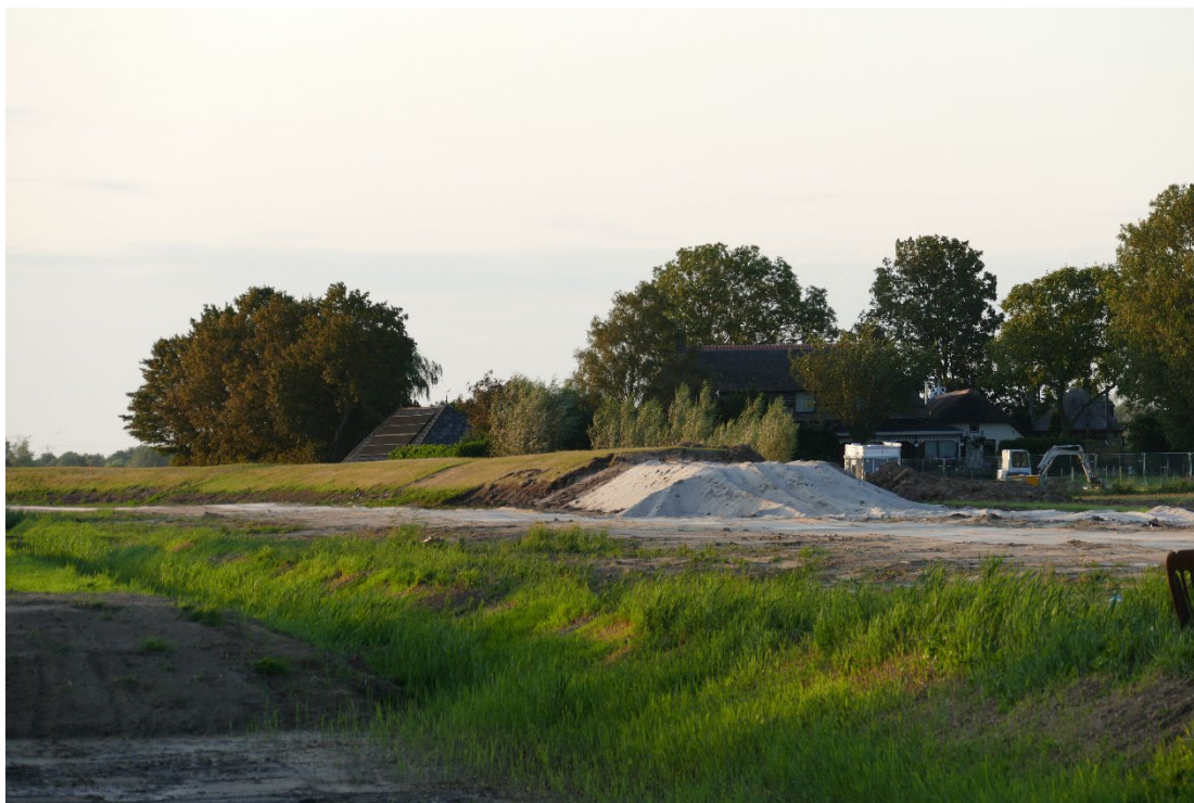
Figuur bijlage A.1 Voorbeeld van een primaire waterkering bestaande uit een zandkern met kleibekleding: de IJsseldijk ter hoogte van het Reevediep (foto: Bianca Hardeman).
