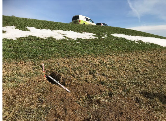
Figuur bijlage A.10 Graverijen in waterzijdig talud (links: Van Dam, 2024:12, rechts: Evers & Cornelisse, 2021:21)
