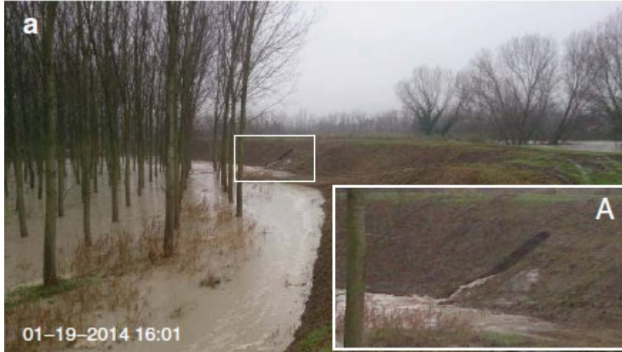
Figuur bijlage A.36 Dijk langs de Panaro nabij Castelfranco Emilia, vanaf de landzijde, met detail van de uitstroming van water. Let ook op de zichtbaar hoge rivierwaterstand aan de andere kant van de dijk (Orlandini et al., 2015).
