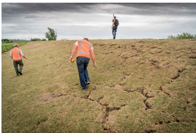
Figuur bijlage A.34 Gevolgen van een muizenplaag (Van Dam, 2024:12).
