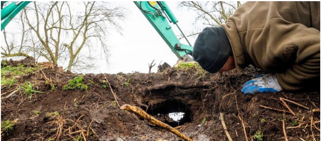
Figuur bijlage A.23 Door een bever doorgegraven regionale kering (Zijkade bij Vianen; foto Waterschap Rivierenland)
