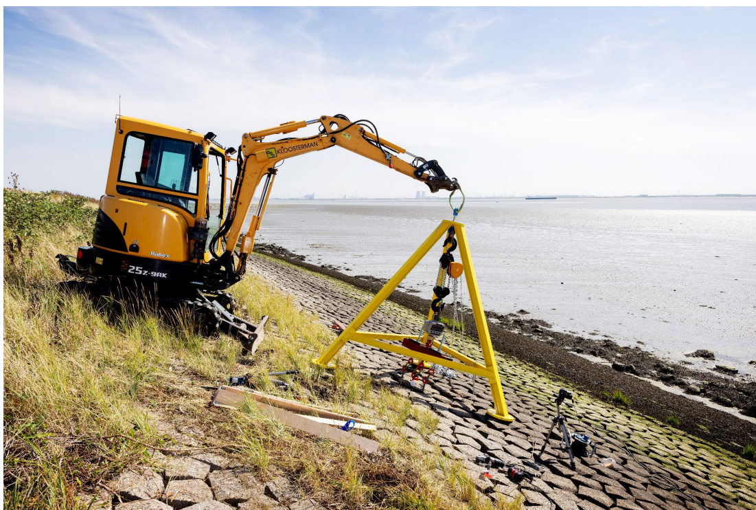
Fig. D-4, Verplaatsen van driepoot tussen de proeflocaties met een 2 tons kraan.
