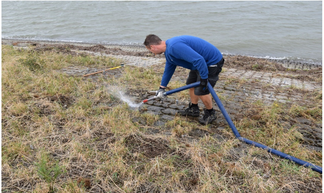
Figuur 3-7, Uitspoelen van inwasmateriaal met een brandslang.
