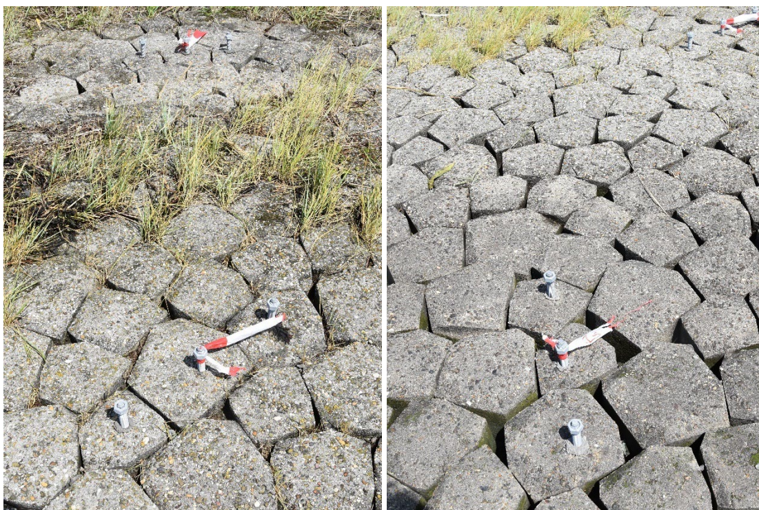
Figuur 3-4, Voorbeelden van een goede (links) en matige (rechts) proeflocatie voor Basalton.
