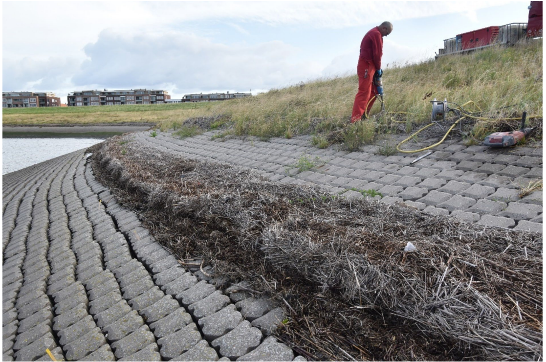
Figuur 3-8, Boren van de gaten waarin chemisch anker en vervolgens ankerstangen werden aangebracht.
