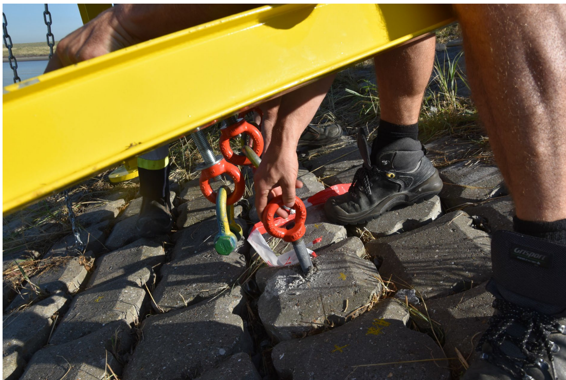
Fig. D-5, Bevestiging van hijsogen aan de ankers in de zetstenen.
