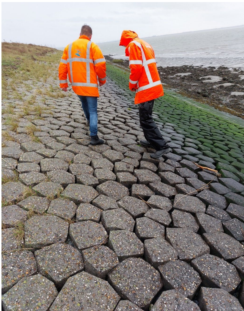
Figuur 3-2, Basalton met deels een afwijkend patroon, waardoor lokaal grote gaten aanwezig zijn.
