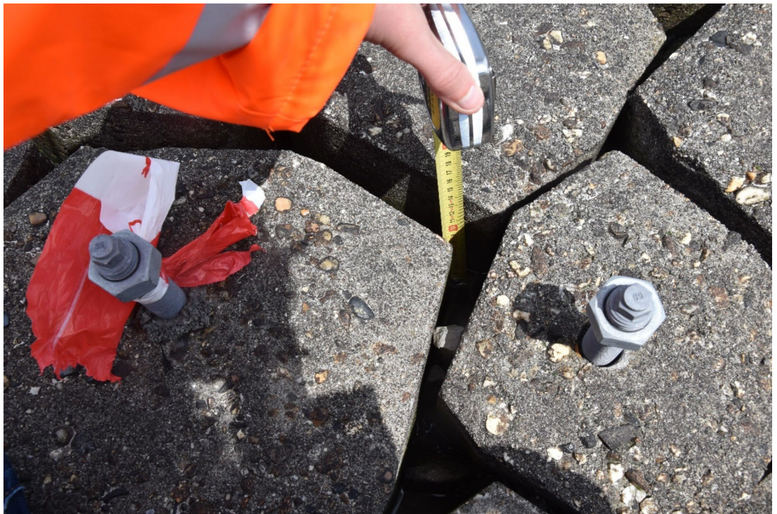
Fig. D-10, Meten van de hoeveelheid uitspoeling tussen de zetstenen.
