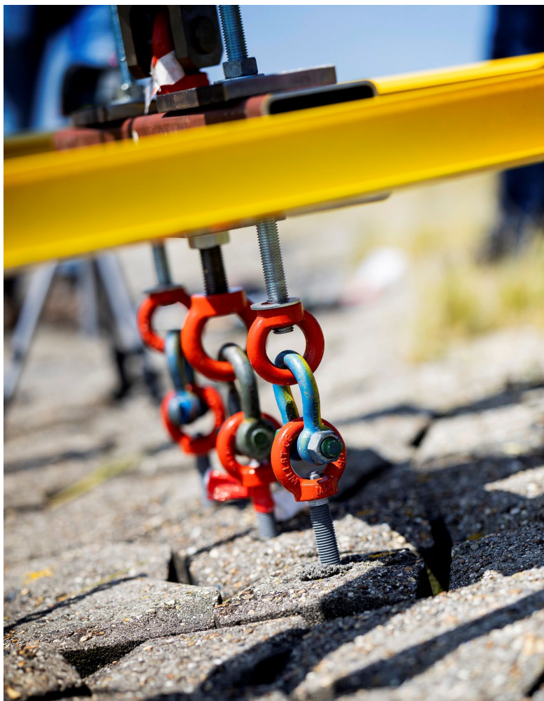
Figuur 3-10, Bevestiging van de hijsconstructie aan de zetstenen (foto van Guus Schoonewille).
