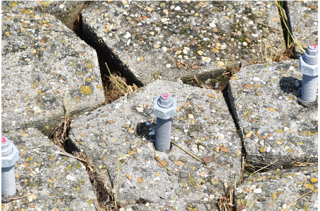
Fig. D-1, Geplaatste ankerstangen.
