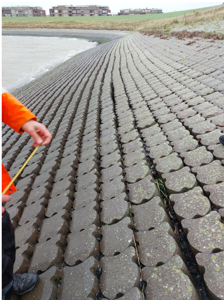
Figuur 3-5, Kammende Hydroblocks, waardoor lokaal brede spleten ontstaan.
