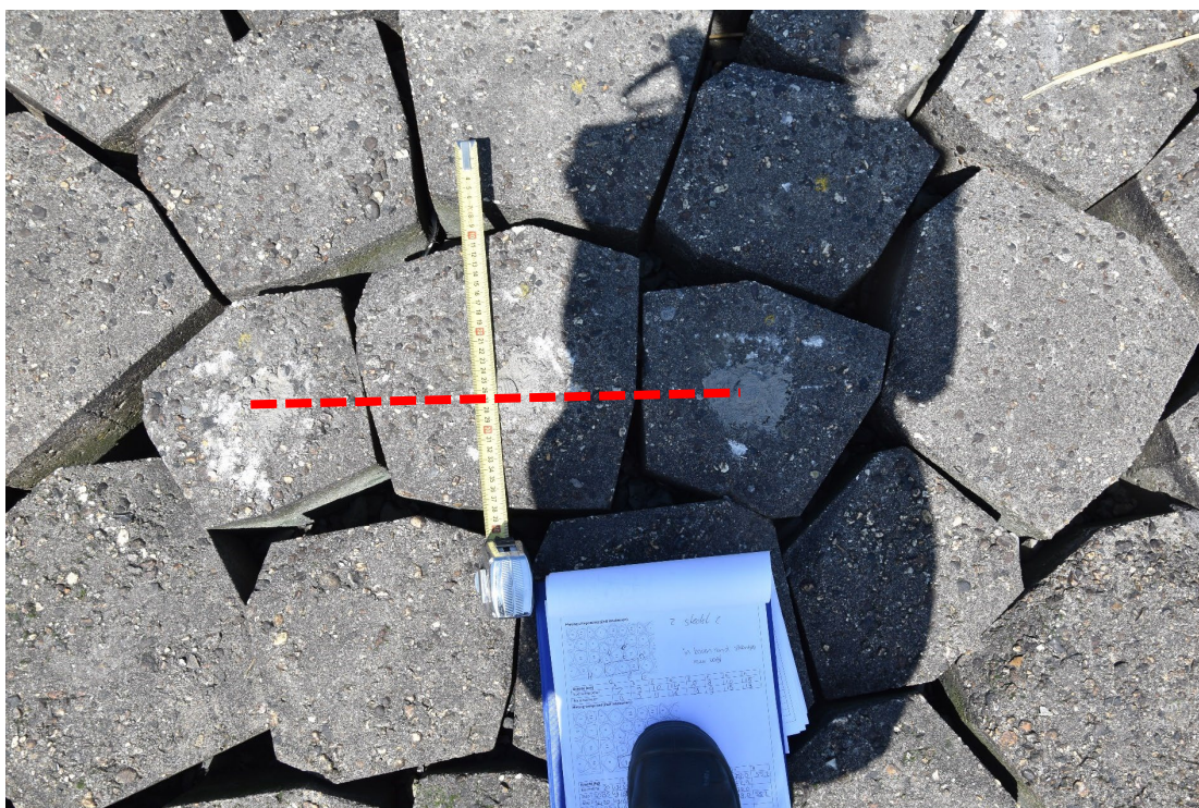
Fig. A-6, Foto van proeflocatie 2 'Basalton matig' (rode stippellijn verbindt de getrokken stenen).
