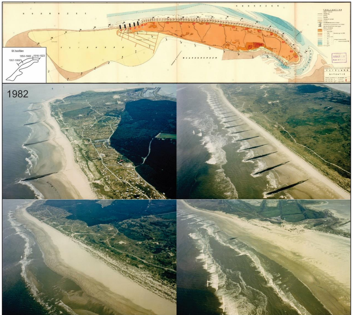
Figuur 2-2: Boven: ligging van de strekdammen aan de hand van een kaart uit Visser (1946), met toegevoegd locatie hoofden C-F. Onder: Impressie van de strekdammen van Vlieland nabij de NO punt (linksboven en -onder), centrale eilandkust (rechtsboven) en overgang naar de Vliehors (rechtsonder). Foto's: https://beeldbank.rws.nl , Rijkswaterstaat. Overgenomen uit Elias 2021b.
