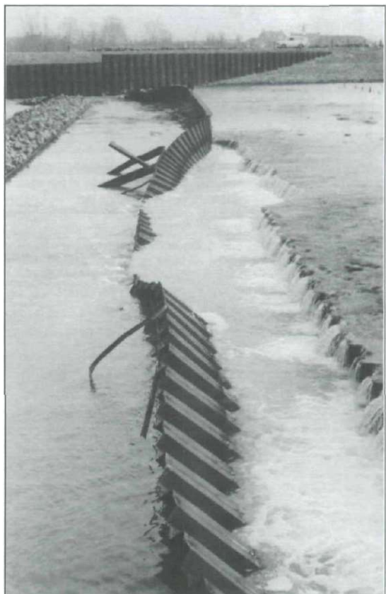
Figuur 11 De oorspronkelijk overlaat bij Pannerden met een damwandconstructie met zijdelingse begrenzing (boven), falen als gevolg van een hoogwater (linksonder) en de nieuwe instelbare constructie met betonnen schotbalken (rechtsonder), die zowel bij Pannerden als Honsbroekse Pleij is toegepast.
