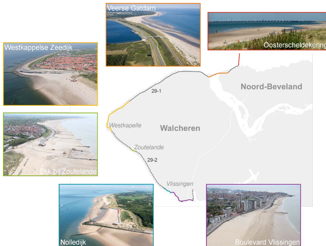
Figuur 4-3. Harde elementen als onderdeel van de kustverdediging op Walcheren en Noord-Beveland, van rechtsboven tegen de klok in: Oosterscheldekering, Veerse Gatdam, Westkappelse Zeedijk, Dijk bij Zoutelande, Nolledijk en de Boulevard van Vlissingen. De lichtgrijze lijnen weergeven de ligging van de strandhoofden en palenschermen langs de kust. Dijktraject 29-1 is weergegeven als donkergrijze lijn en dijktraject 29-2 als donkergrijs gestreepte lijn.
