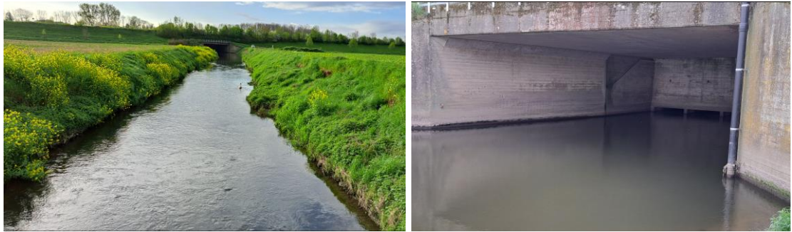
Figuur 4.8 Sifon waar de Geleenbeek onder het Julianakanaal doorstroomt, gezien vanaf de westelijke kant van het Julianakanaal (foto's: N. Asselman).
