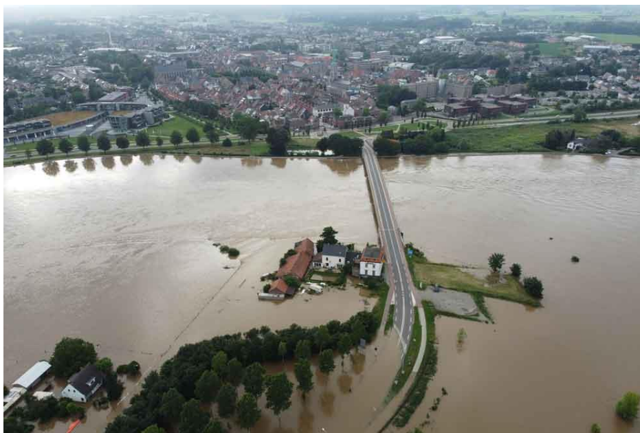
Figuur 8.1 Toegangsweg Pater Sangersbrug aan Nederlandse zijde overstroomd tijdens hoogwater juli 2021 (foto: Consortium Grensmaas/Flying Eye)
