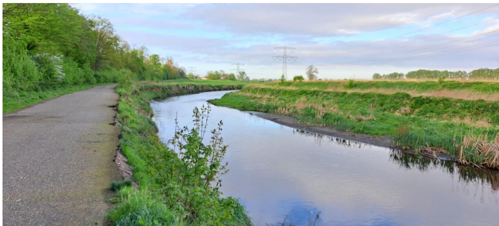
Figuur 3.10 Ondermijning van de weg langs de Oude Maas door oevererosie nog zichtbaar voorjaar 2024 (foto N. Asselman)
