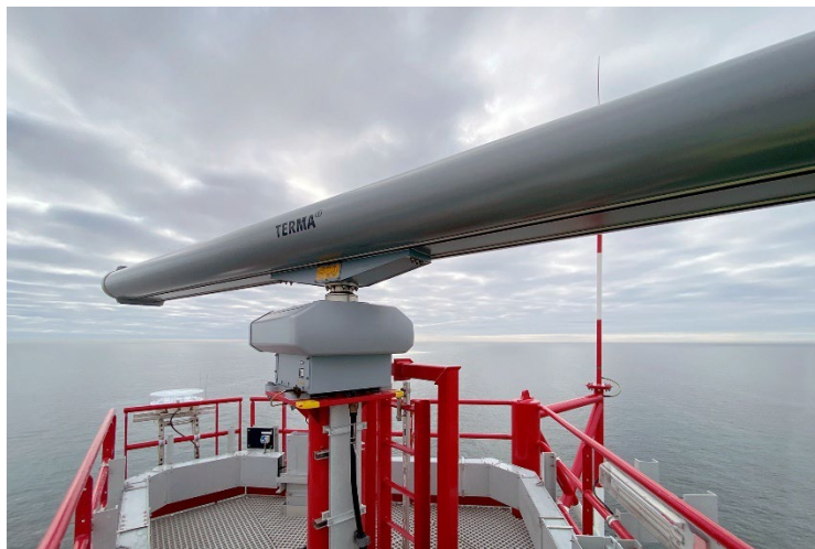
Figuur 2.6: radarantenne op een platform (beeld: Robert Keupers via digitalenordzee.nl)
