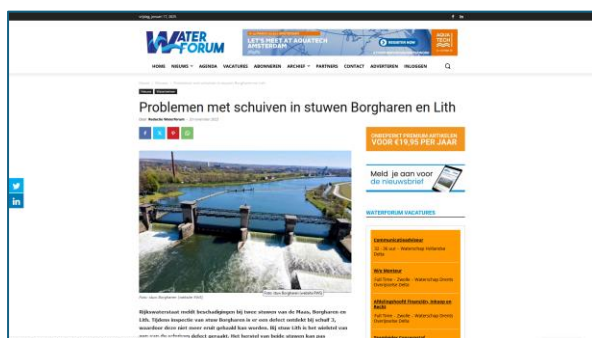
Figuur 2 De stuwen in de Maas zijn steeds vaker defect. Bron: Waterforum .
