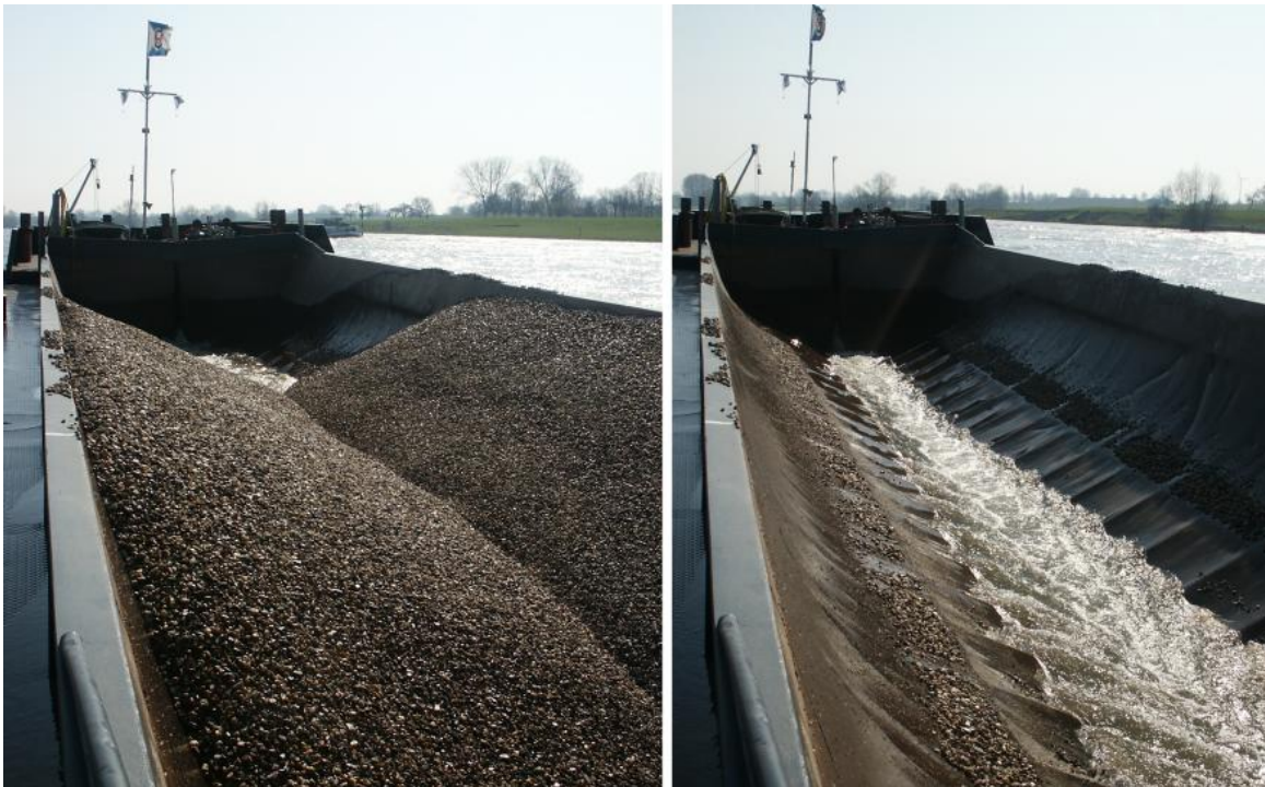
Figuur 2.9 Sediment suppletie bij Rees (Duitsland) met behulp van een onderlader
