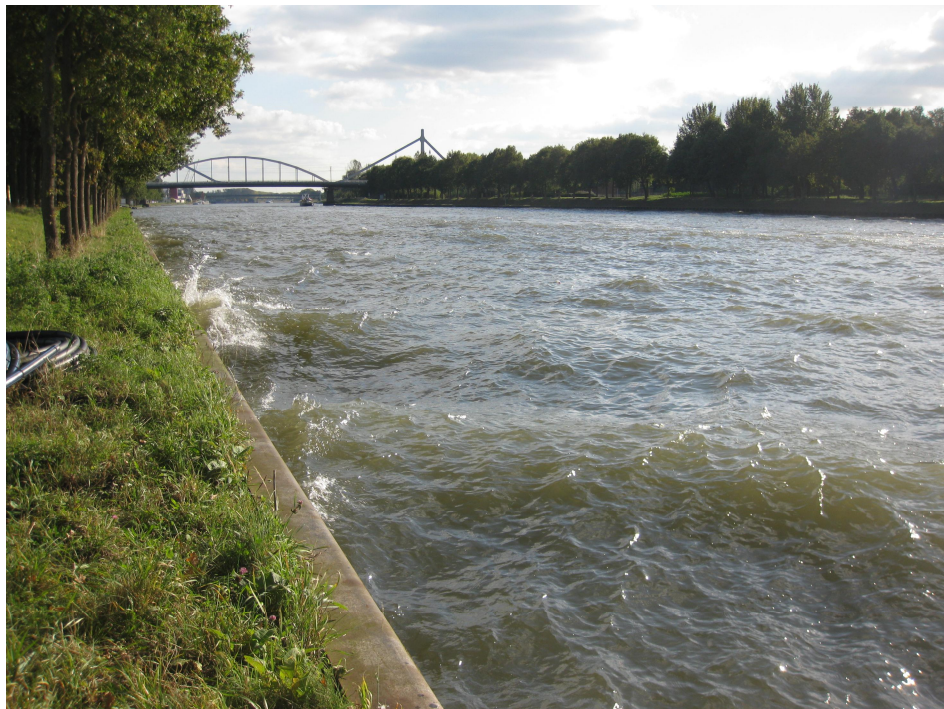
Figuur 4.8 Interferentiepieken die door een passerend binnenvaartschip zijn veroorzaakt, weerkaatsen tegen de damwand aan de oostelijke oever van het Amsterdam-Rijnkanaal nabij Utrecht, 14 oktober 2009.
