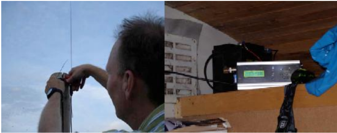
Figuur 3-19 Antenne van de automatische uitleesapparatuur die op een paal gemonteerd wordt met daaraan verbonden het ontvangstation.
