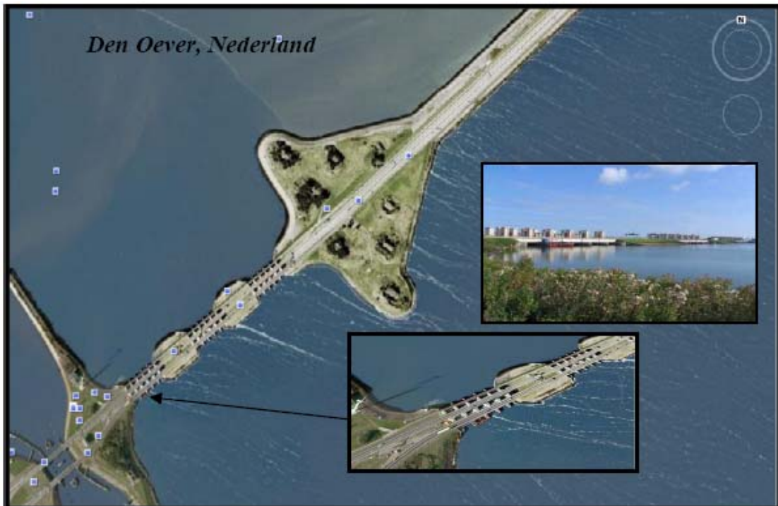
Figuur 1 Stevinssluisen complex in de afsluitdijk te Den Oever. De pijl wijst op de locatie van de Tocardo turbine pilot, Augereau 2009
