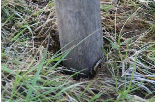
Foto 3.5 Ontgraving rondom een paaltje
