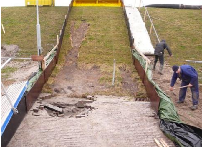
Foto 3.4 Ontgraving bij teen talud
