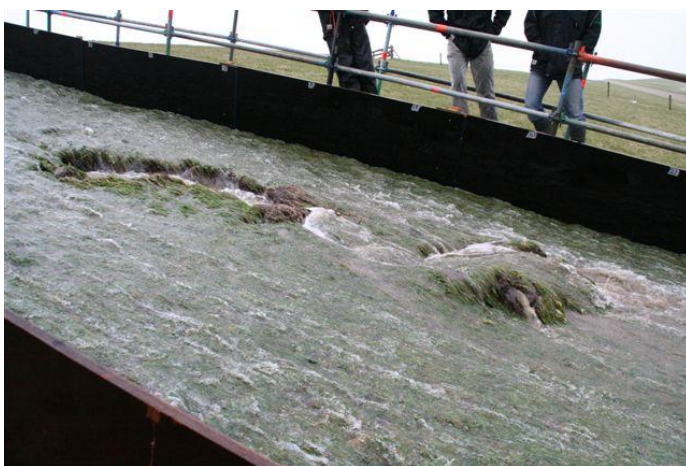
Foto 3.3 Abrupt losscheuren ("opbolmechanisme")
