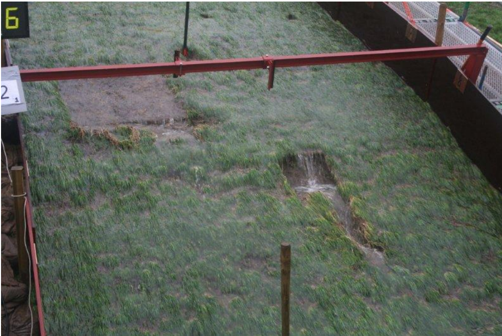
Foto 36 Delfzijl. Grastalud. Initiële schade aangebracht op het talud.
