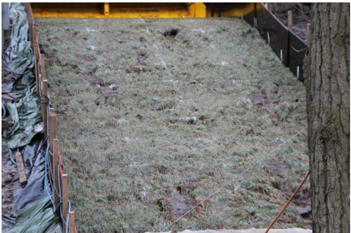
Foto 16. Vechtdijk. Zeeregime met boom, proef 2; Gestopt, talud niet bezweken.
