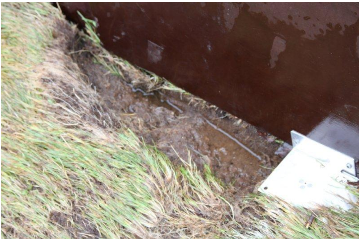
Foto 27. Vechtdijk. Hydraulische metingen; Na de metingen.
