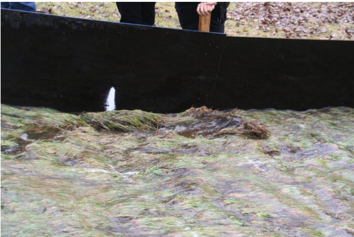
Foto 2. Vechtdijk. Rivierregime, proef 4; Eerste schade
