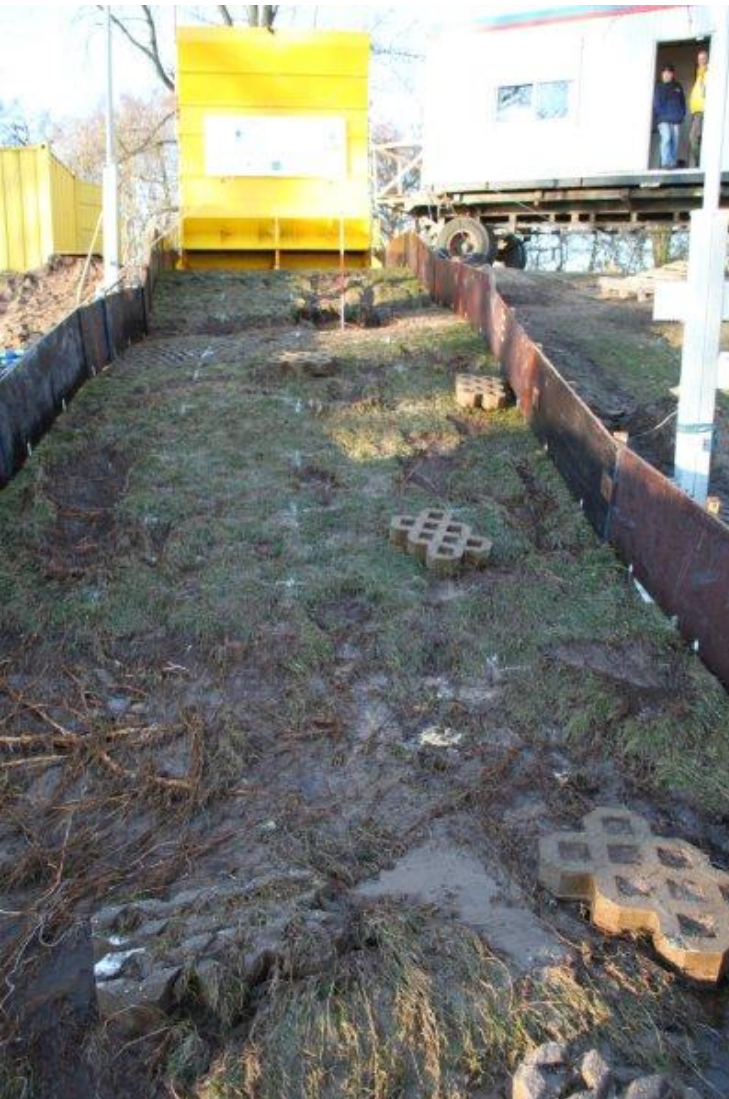
Foto 10. Vechtdijk. Zeeregime met overgang, proef 1; Talud na de proef niet bezwiken.
