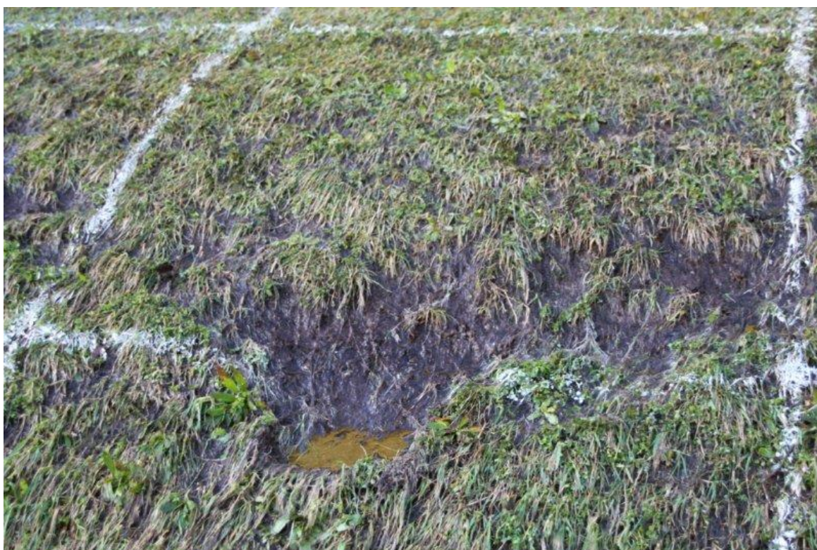
Foto 8. Vechtdijk. Zeeregime met overgang, proef 1; Eerste schade talud.
