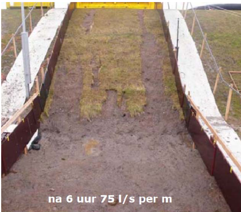
Figuur 53. Afsluitdijk. Sectie 1. Erosie van de teen 0,30 m diep; talud wel kaal, maar niet bezweken.
