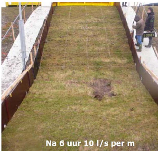
Figuur 50. Afsluitdijk. Sectie 1. Begin van schade aan teen.
