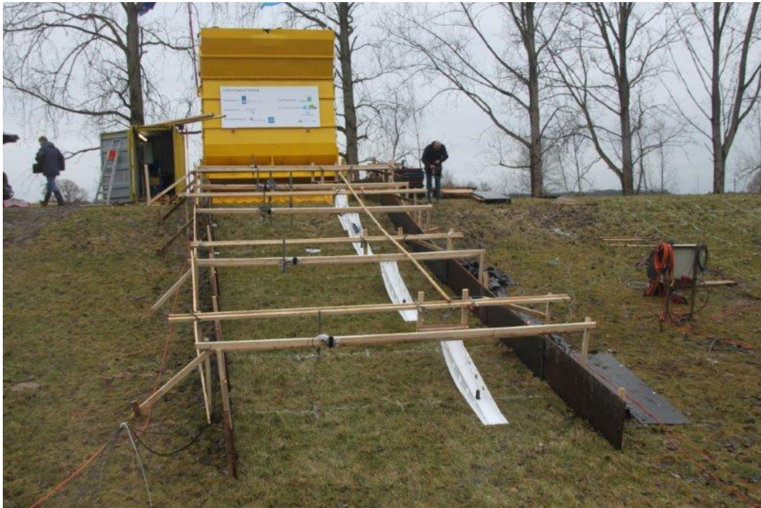
Figuur 2.41 Meetopstelling met alle surfplanken
