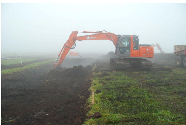
Op diepte graven sloot proef 3
