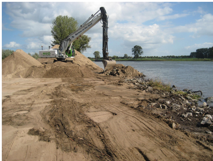
Figuur 3.46. Graafwerkzaamheden bij de Zandmeren (foto: Frans Kerkum).
