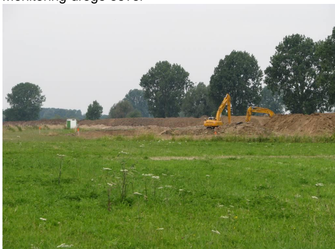
Figuur 3.48 Graafwerkzaamheden in de oevers bij Ossenkamp (foto Pepijn Calle).
