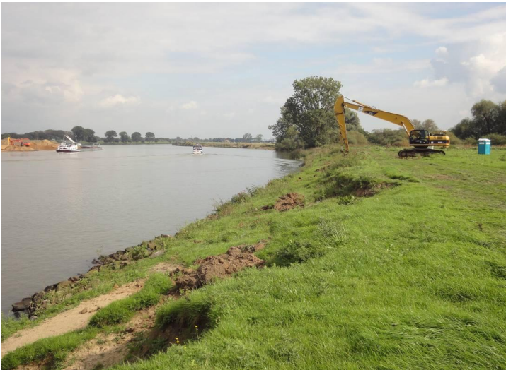
Figuur 3.42 Proefsleuven in de hoge oever aan de oostzijde. Deze oever is zeer kansrijk voor een hoge vrij eroderende oever (foto Bart Peters).
