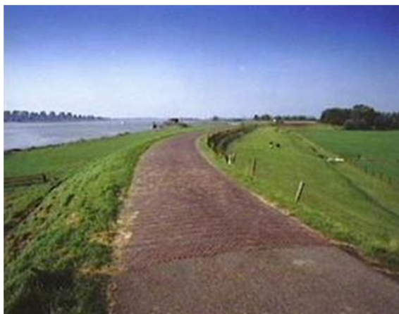
Figuur 3.5 Dalemse overlaat (tussen Vuren en Dalem). Het beklinkerde deel van de dijk kan worden weggeschoven tijdens een overstroming om het water terug te laten stromen naar de rivier. (beeldbank.rws.nl, Rijkswaterstaat / Henri Cormont)
