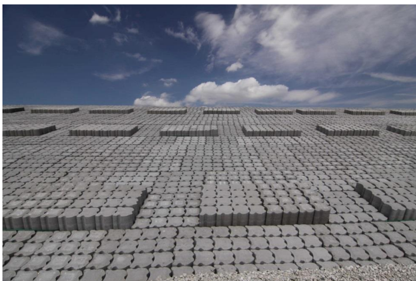
Figuur 3.1 Voorbeeld van een bijzonder patroon ten behoeve van de golfverslagreductie (Zoutelande, Zeeland)
