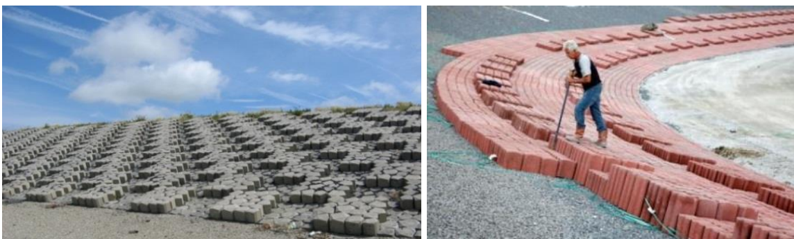
Figuur 1.2 Dambordpatroon van Basalton op Hondsbosse Zeewering (links) en patroon van Hydroblocks bij Breskens (rechts)
