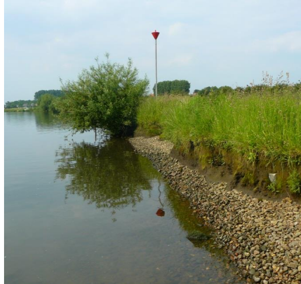
Oever bij Aijen. Het erosieprofiel is goed te zien, met daarbij de oever bestaande uit grof grind (B. Rijksen 2015).
