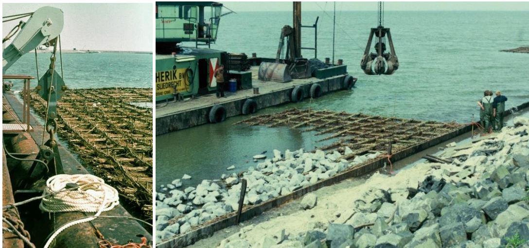
Figuur 2.2 Aanleg oeverwerk; links positioneren zinkstuk, rechts bestorten van een zinkstuk (foto's RWS Beeldbank).
