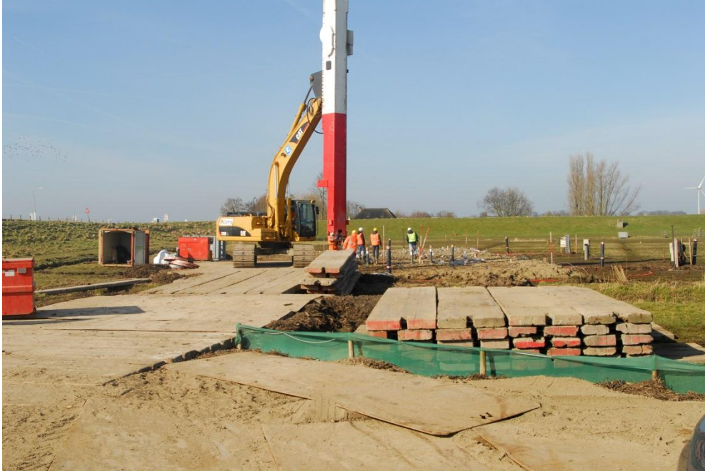
Figuur 3.13 Verticale drains worden ingebracht. De drains zijn weggedrukt tot NAP-8,7. De locaties zijn ingemeten in RD-coördinaten
