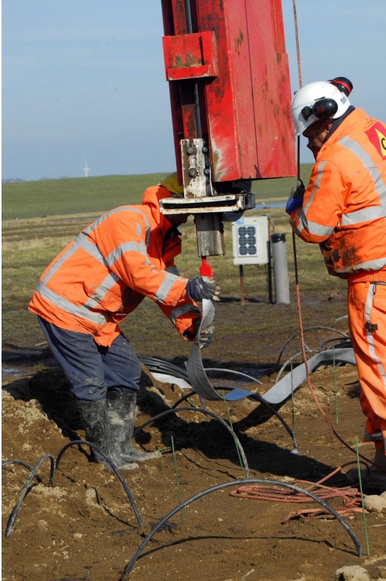
Figuur 3.18 De geprefabriceerde drains worden in de makelaar getrokken en daarna op diepte weggedrukt
