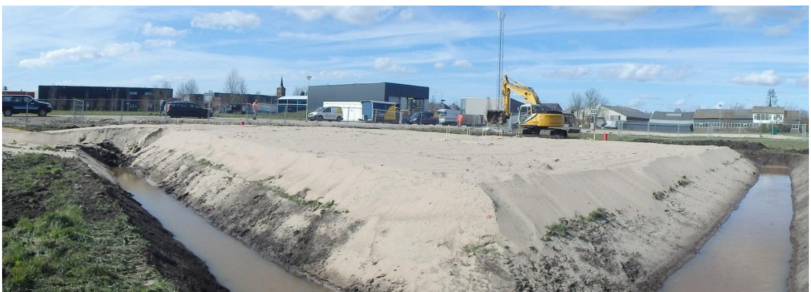
Figuur 3.4 Gegraven sloten rond het proefvak
