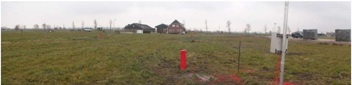
Figuur 4.11 Hellingmeetbuis en aansluitkast voor de waterspanningsmeters
