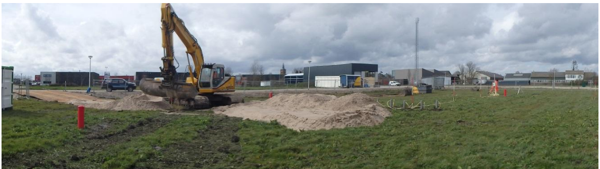
Figuur 3.3 Aanbrengen drainagezand
