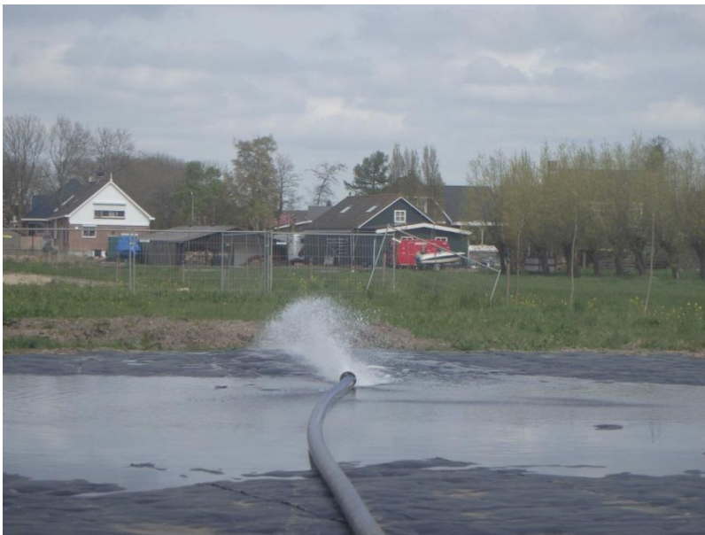
Figuur 3.11 Het water uit het slappe lagen pakket wordt op het proefvak geloosd
