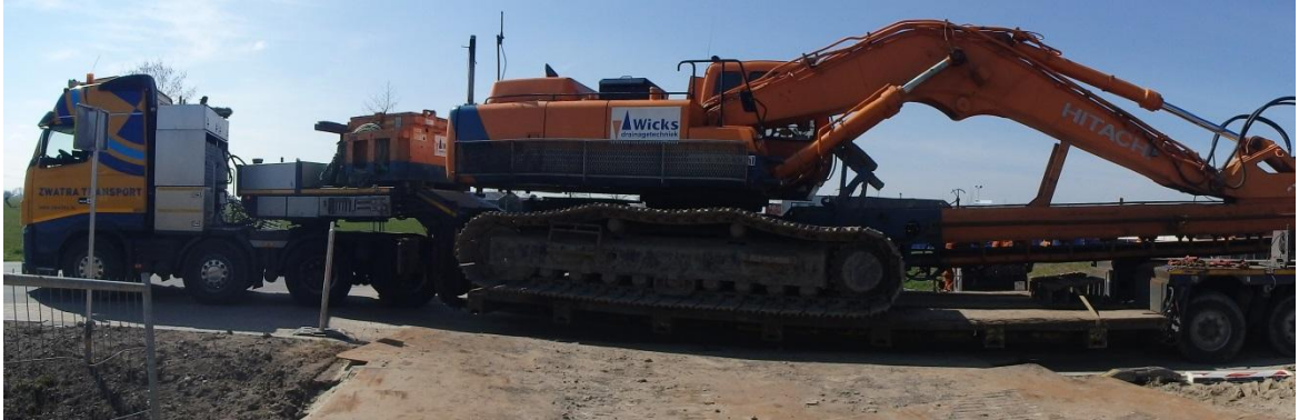
Figuur 3.7 De rupskraan waarmee de verticale drains worden aangebracht
