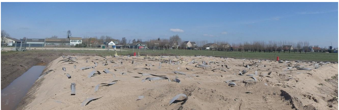
Figuur 3.6 Verticale drains geplaatst (Linten)
