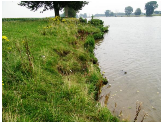
Coehoorn 2: Begroeiing en kleilig materiaal vertragen de erosie.
