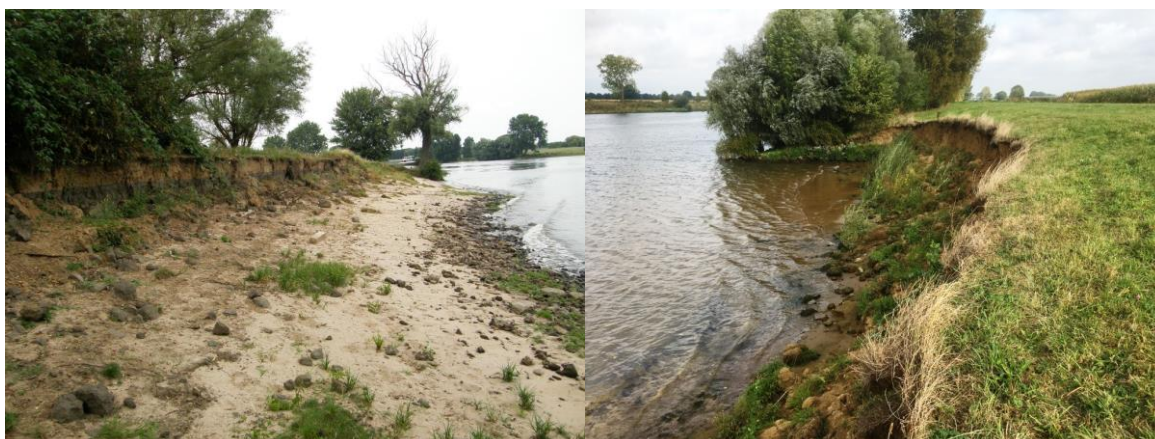
Figuur 2.1 Vrije erosie op de oevers na verwijdering van de stortstenen bij de Zandmeren (links) en Zuidereiland ten zuiden van Heijen (rechts)(2016)
