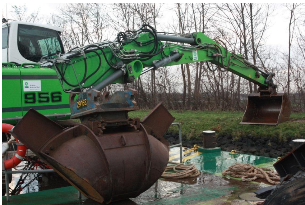
Figuur 3.1 Graafmachine op het ponton waarmee het materiaal van de bodem van het kanaal omhoog werd gehaald.
