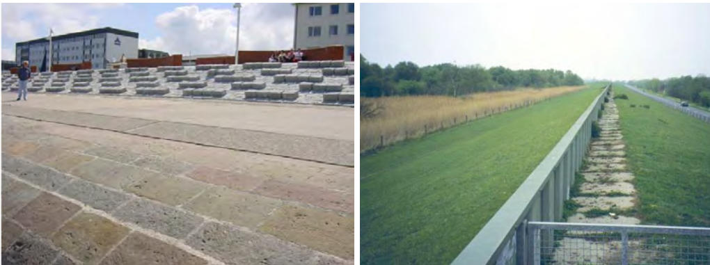
Figuur 1.3 Voorbeeld van aangebrachte ruwheid op het talud (links, foto: Schüttrumpf) en dijk met verticale kruinmuur (rechts, foto: Hofstede)
