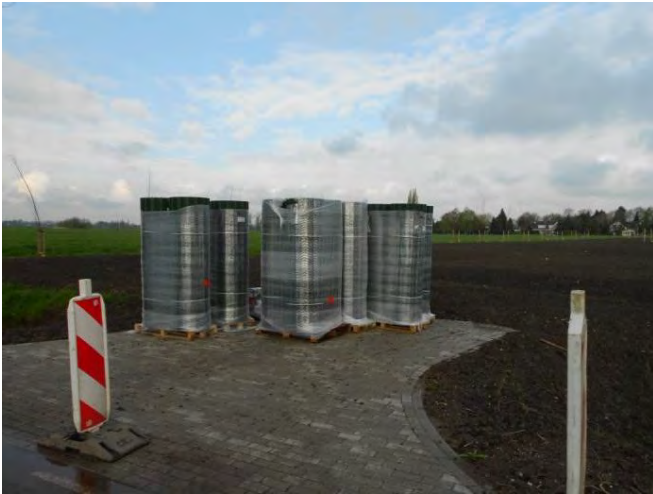
Start aanleg "overloopparkerplaats" met toegangspad. GrassProtecta rollen op pallets en inzaai.
