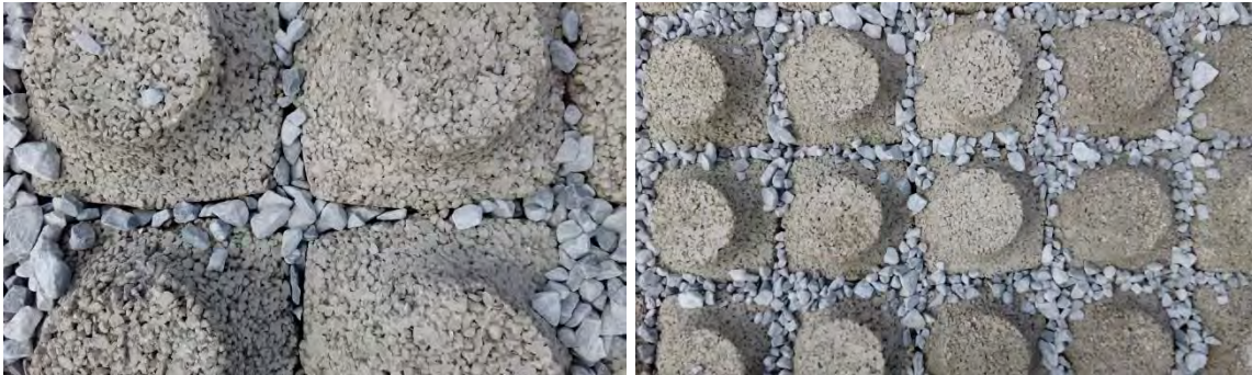
Figuur 4.47 Testsectie TS B.2a (Grassblocks) tijdens aanleg
