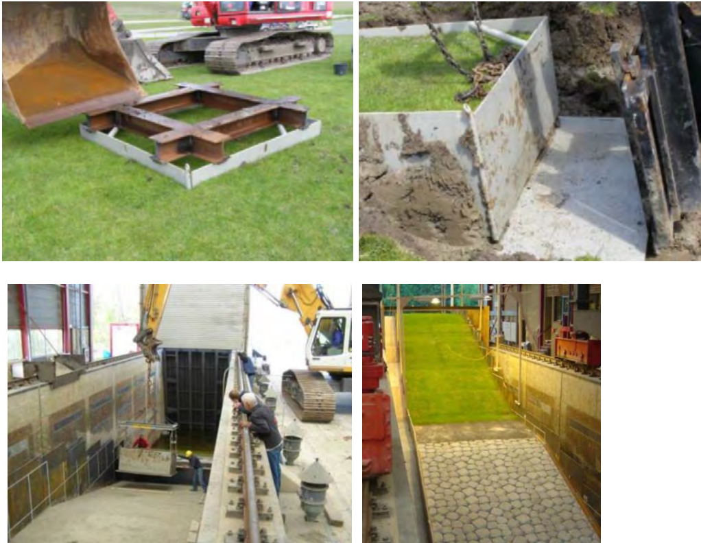
Figuur C.5 Steken van blokken op een dijk (boven), plaatsen van de blokken in de Deltagoot (linksonder). Het uiteindelijke resultaat (rechtsonder)
