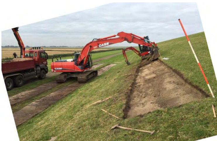
Figuur 4.3 Ontgraven van de testsecties tot een diepte van 20 cm. Op basis van de indruk die hier werd verkregen is besloten om de testsectie uit te graven tot een diepte van 40 cm.
