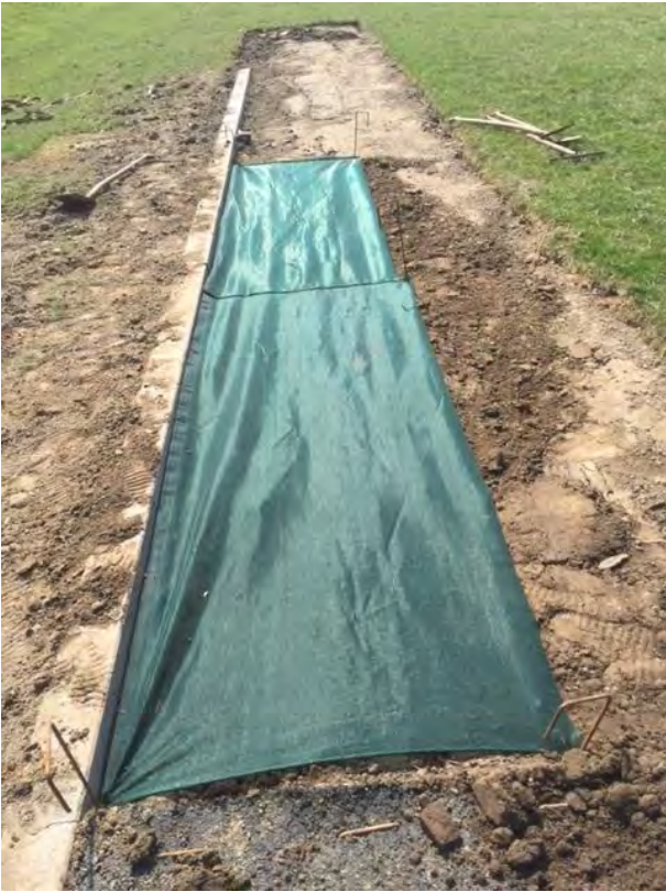
Figuur 4.15 Impressie TS A.2a (doorgroeitextiel: Geopex) tijdens aanleg (de pennen zijn verwijderd nadat het doek is afgedekt met teelaarde)
