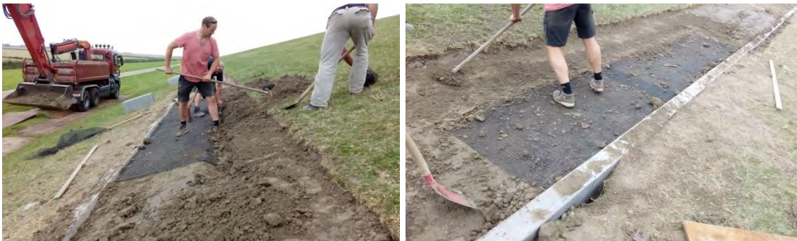
Figuur 4.28 Testsectie TS A.2d (Fortrac 3D-60) tijdens aanleg
