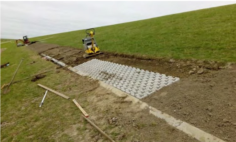
Figuur 4.57 Grasbetontegel na aanleg
