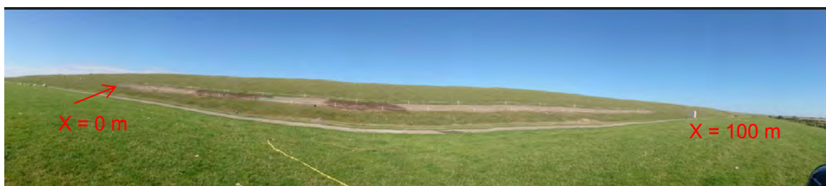
Figuur 3.3 Overzicht van alle testopstellingen direct na aanleg
