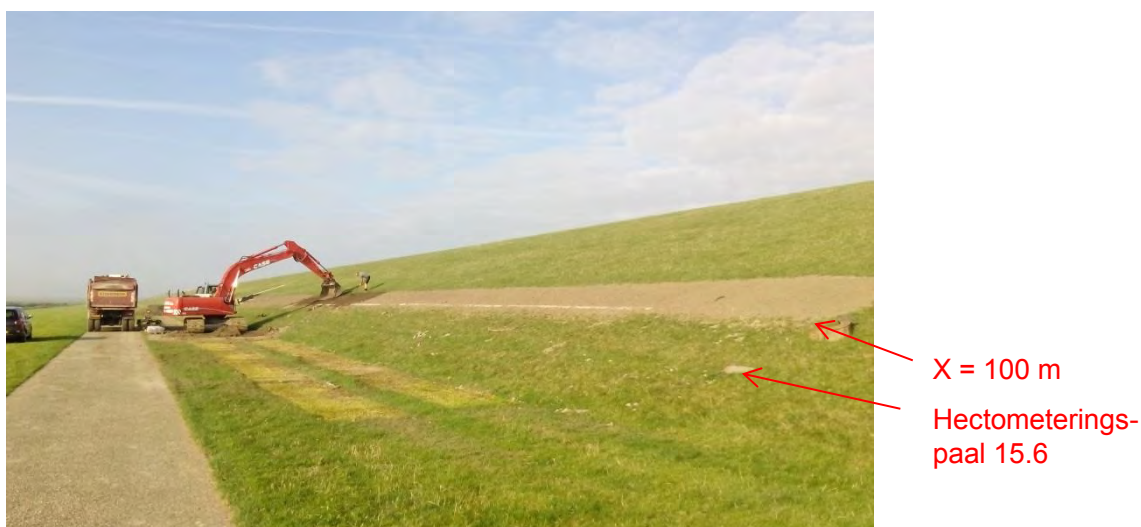
Figuur 3.4 Impressie van testopstelling (tijdens aanleg)
