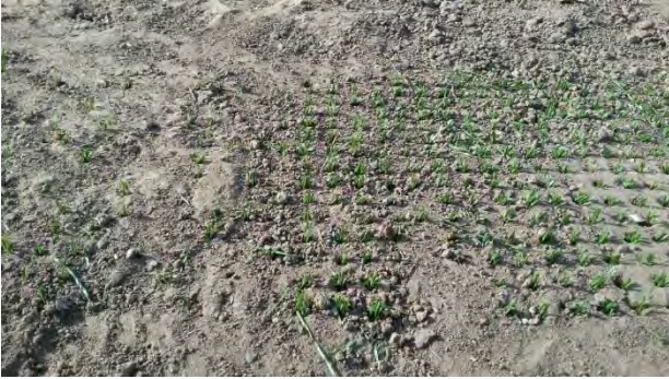
Figuur 4.41 Testsectie TS A.2e (GrassMaster) tijdens aanleg.
