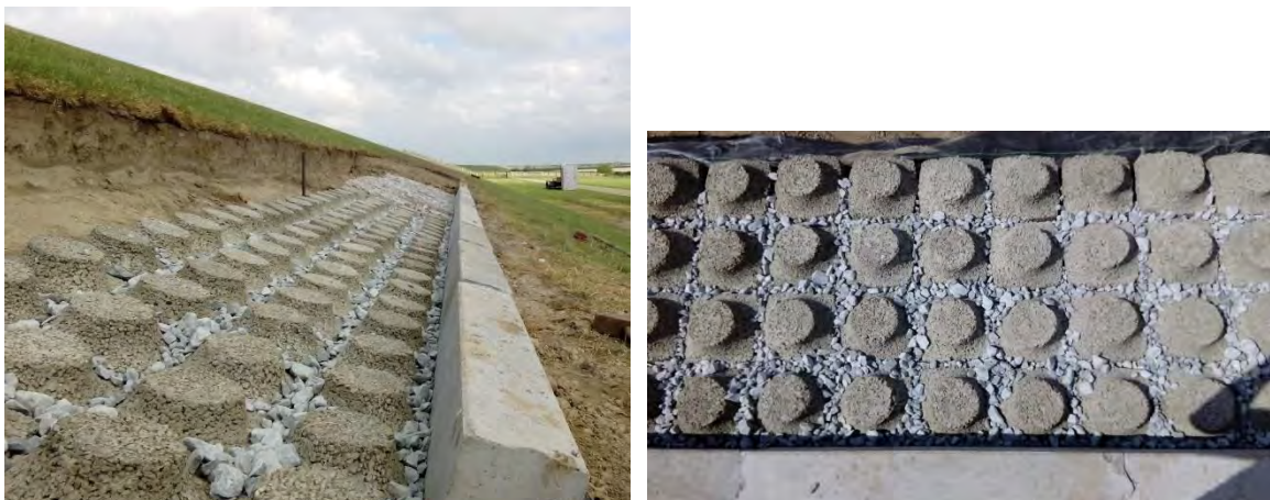
Figuur 4.46 Testsectie TS B.2a (Grassblocks) tijdens aanleg
