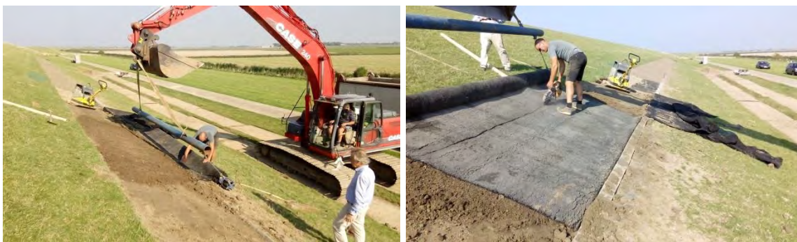
Figuur 4.19 links: aanbrengen van de Enkamat met evenaar. Rechts: doorslijpen van de Enkamat
