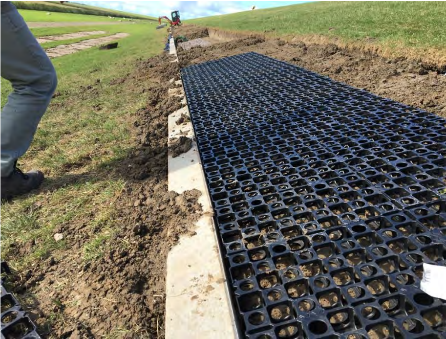
Figuur 4.62 Impressie plastic raster tijdens aanleg
