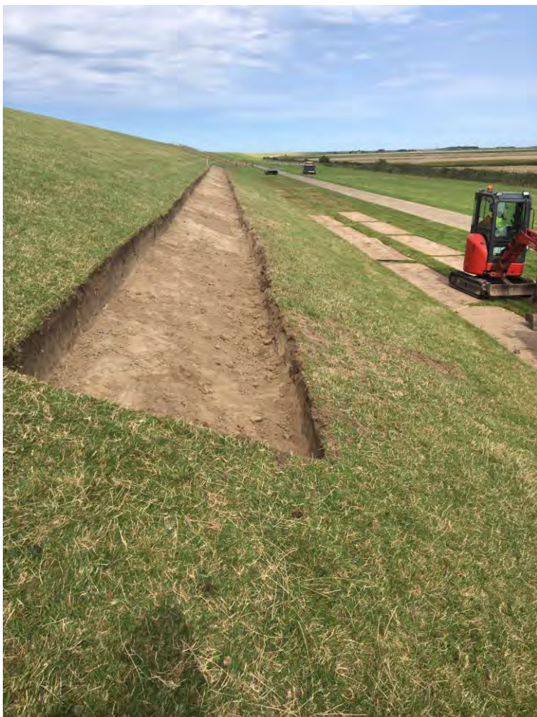
Figuur 4.4 Situatie na volledig ontgraven van de klei
