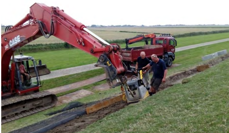
Figuur 4.6 Verdichten van de aangebrachte klei met behulp van een trilplaat
