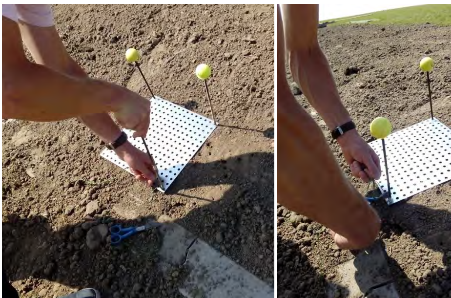
Figuur 4.39 Testsectie TS A.2e (GrassMaster) tijdens aanleg. Links: een pin wordt in een gaatje van het tijdelijke rooster geprikt. Deze pin is bevestigd aan de draad. Rechts: de pin zit op de uiteindelijke diepte en het draadje wordt doorgeknipt
