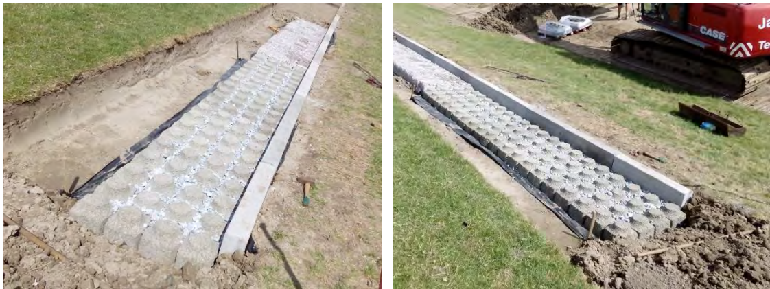
Figuur 4.45 Testsectie TS B.2a (Grassblocks)
