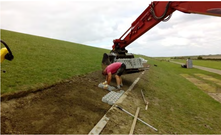
Figuur 4.56 Impressie van het aanbrengen van de grasbetontegel
