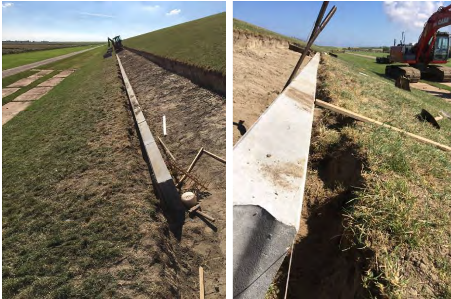
Figuur 4.5 Aanbrengen van de betonbanden. De betonbanden steken circa 1 cm boven maaiveld uit (de werkelijke afstand varieert door de variatie in de hoogte van het maaiveld)
