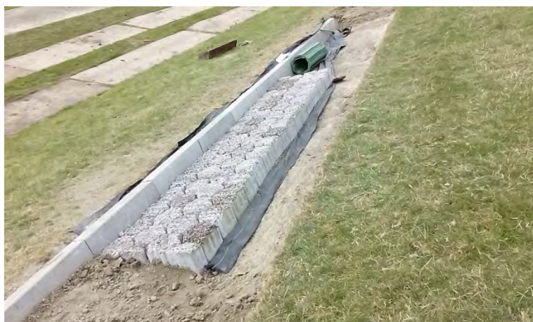
Figuur 4.51 Impressie RONA ® ton na aanleg (nog niet ingewassen)
